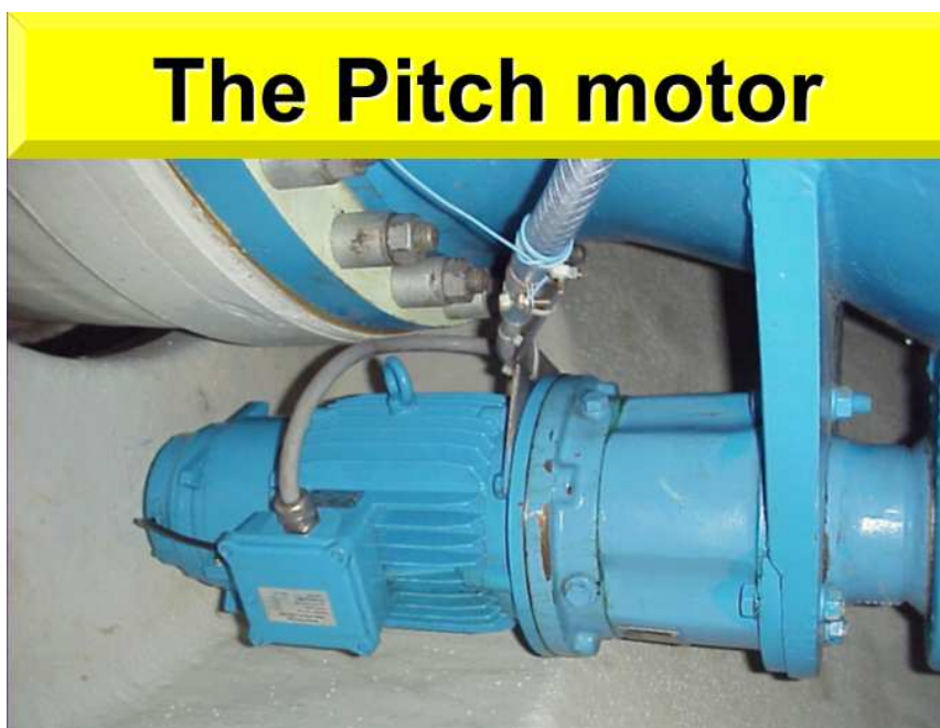
圖六、旋翼控制馬達
