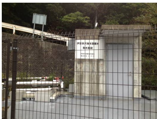
圖 5-5 赤澤海洋深層水取水設施入口
