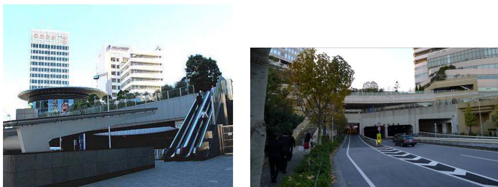
圖 3-13 利用人工地盤及人行天橋區分人車動線營造友善的人行空間
