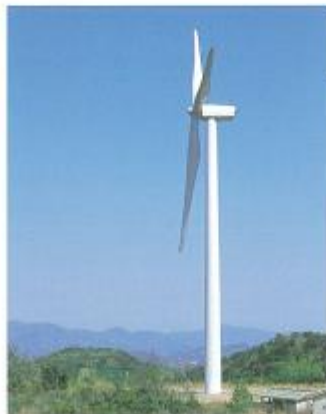
风力发电设备
