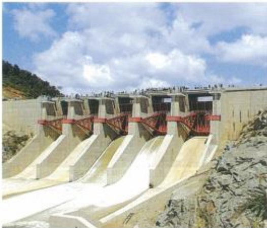
HamTsam发电厂水闸铁管设备(越南)
