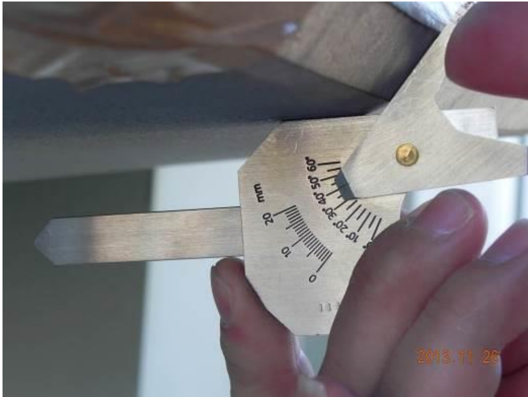
銲道開槽角度檢查
