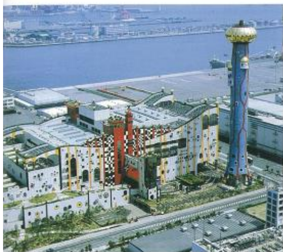
大阪市舞洲工厂 / 炉排炉
