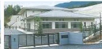
最终处理厂出水处理设施
