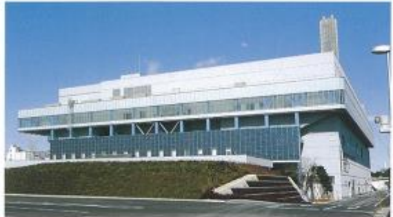
东京二十三区清扫一部事务组合品川清扫工厂 / 炉排炉
