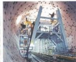
衬砌螺钉的自动紧固装置
