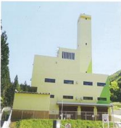
大馆清污中心/炉排炉
