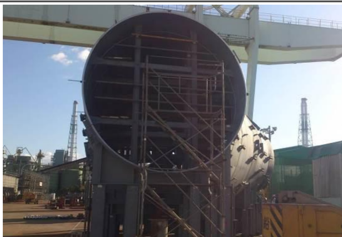
分岐管上游面(内径 4.5 米)
