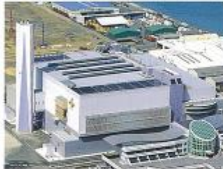
福冈市临海工厂(临海绿色公园) / 炉排炉
