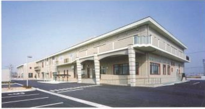
污泥再生处理中心
