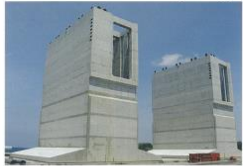
ケーソン Caisson
