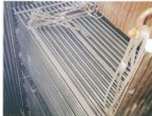
延长使用寿命的工程(更新锅炉侧3烟道)
