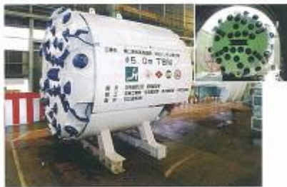
φ5米开放式隧道挖掘机：公路隧道的建设
