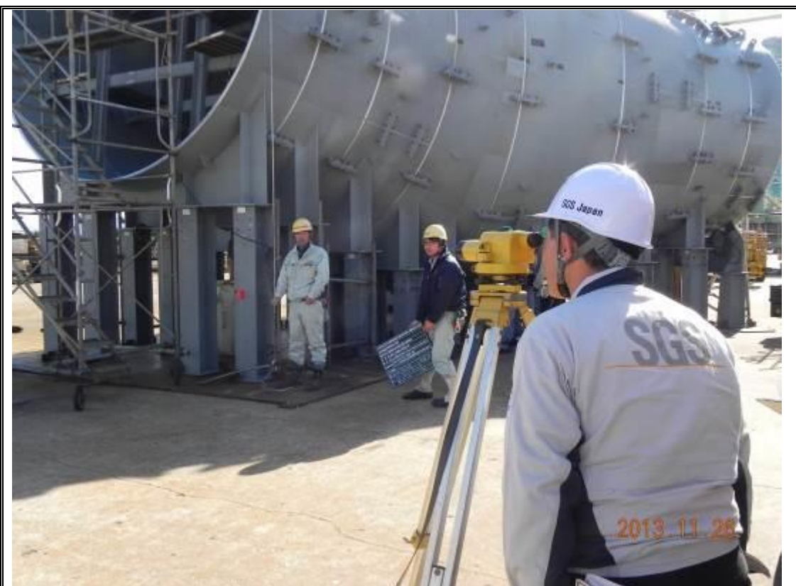
鋼管斜率檢驗
