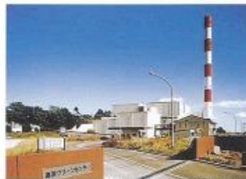
高滨清洁中心 / 炉排炉、超级垃圾发电
