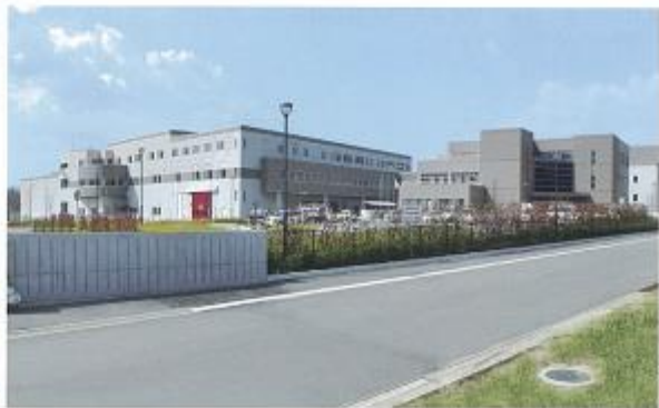
高松市南部清污中心/气化炉融炉
