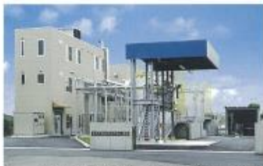
生化柴油燃料化设施(京都市康食用油燃料化设施)
