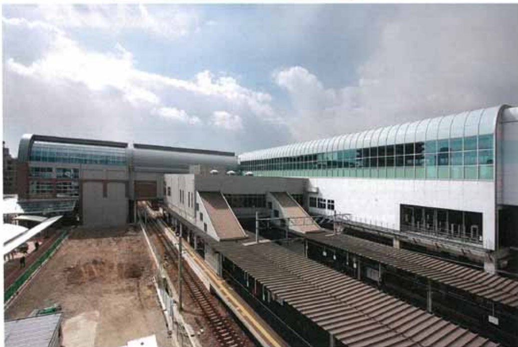
九州新幹線久留米駅 外観
