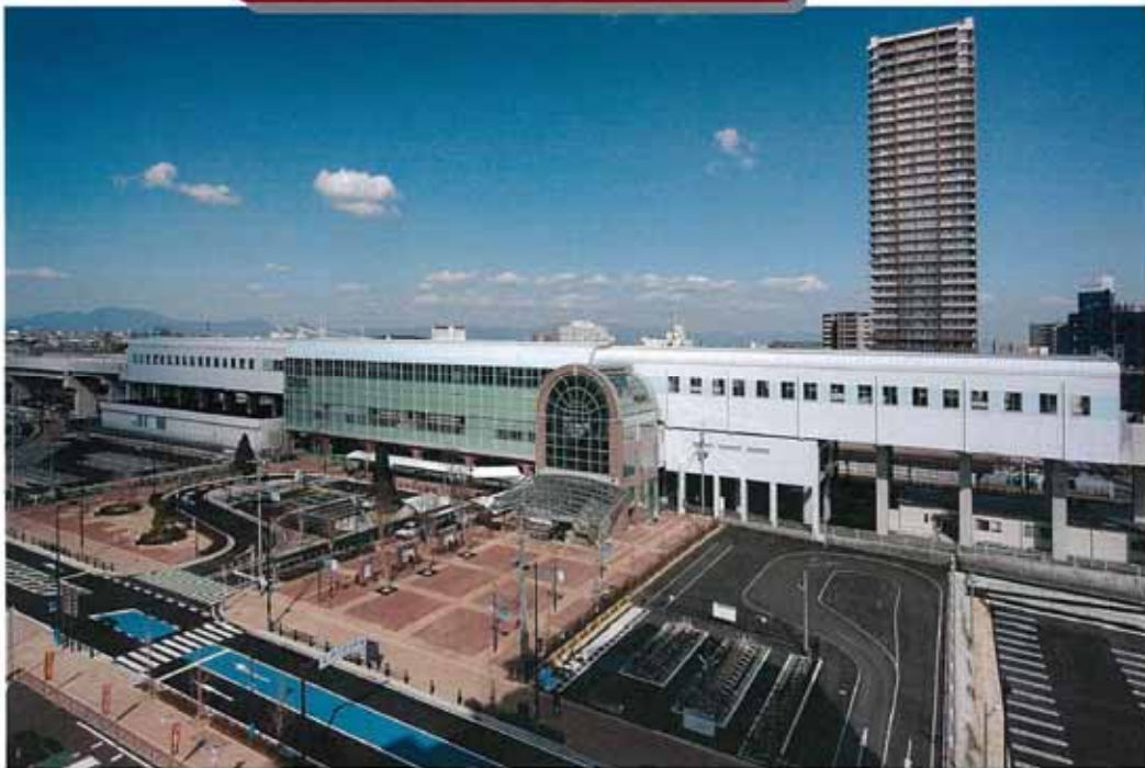
九州新幹線久留米駅 外観
