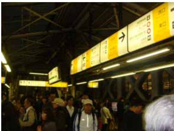
月台上縱橫配設引導標示牌
