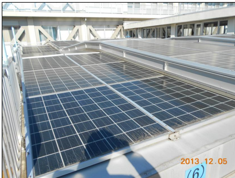
圖 66:東村山淨水場過濾池上蓋加太陽能板
