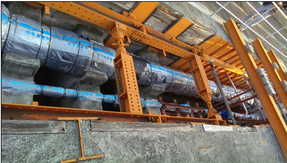
圖 55:管溝擋土設施種類及識別場地
