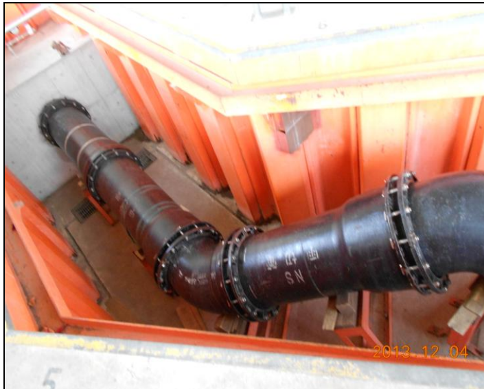
圖 43:500m/mDI 彎頭、短管之裝接
