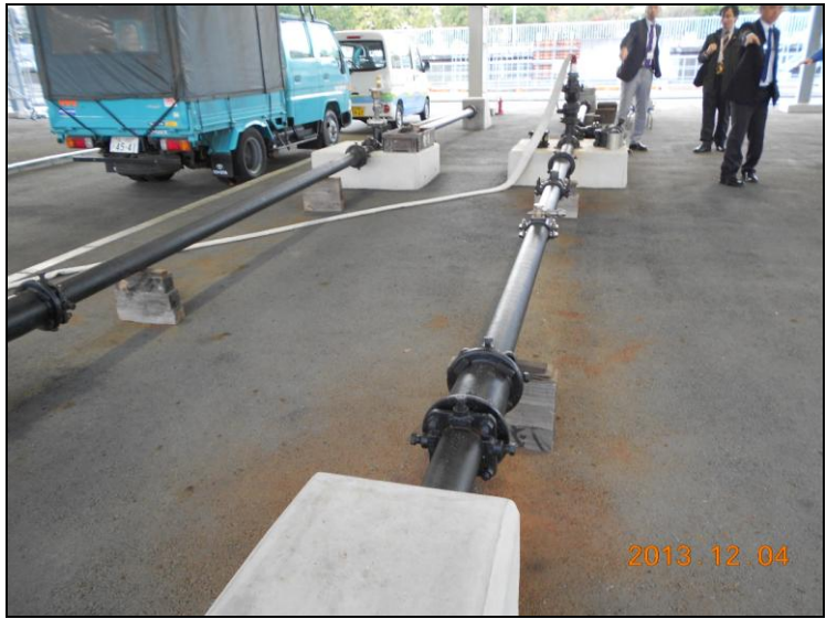
圖 51:配管安裝訓練場地
