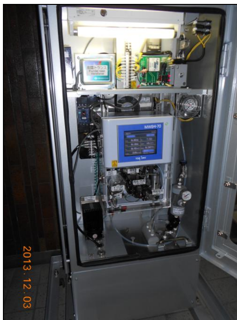
圖 35.水道局水質中心自動水質監測器
