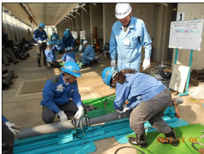
圖 45:小口徑(75~200m/m) GX 接頭裝配之訓練場地
