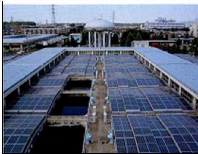
圖 61:東村山淨水場快濾池
