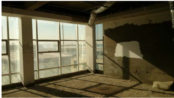
興建中的實驗室大樓
