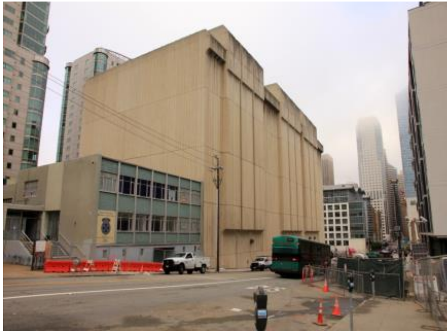
圖 參-40 美國 PG&E 位於舊金山市中心之 Embarcadero 變電所
