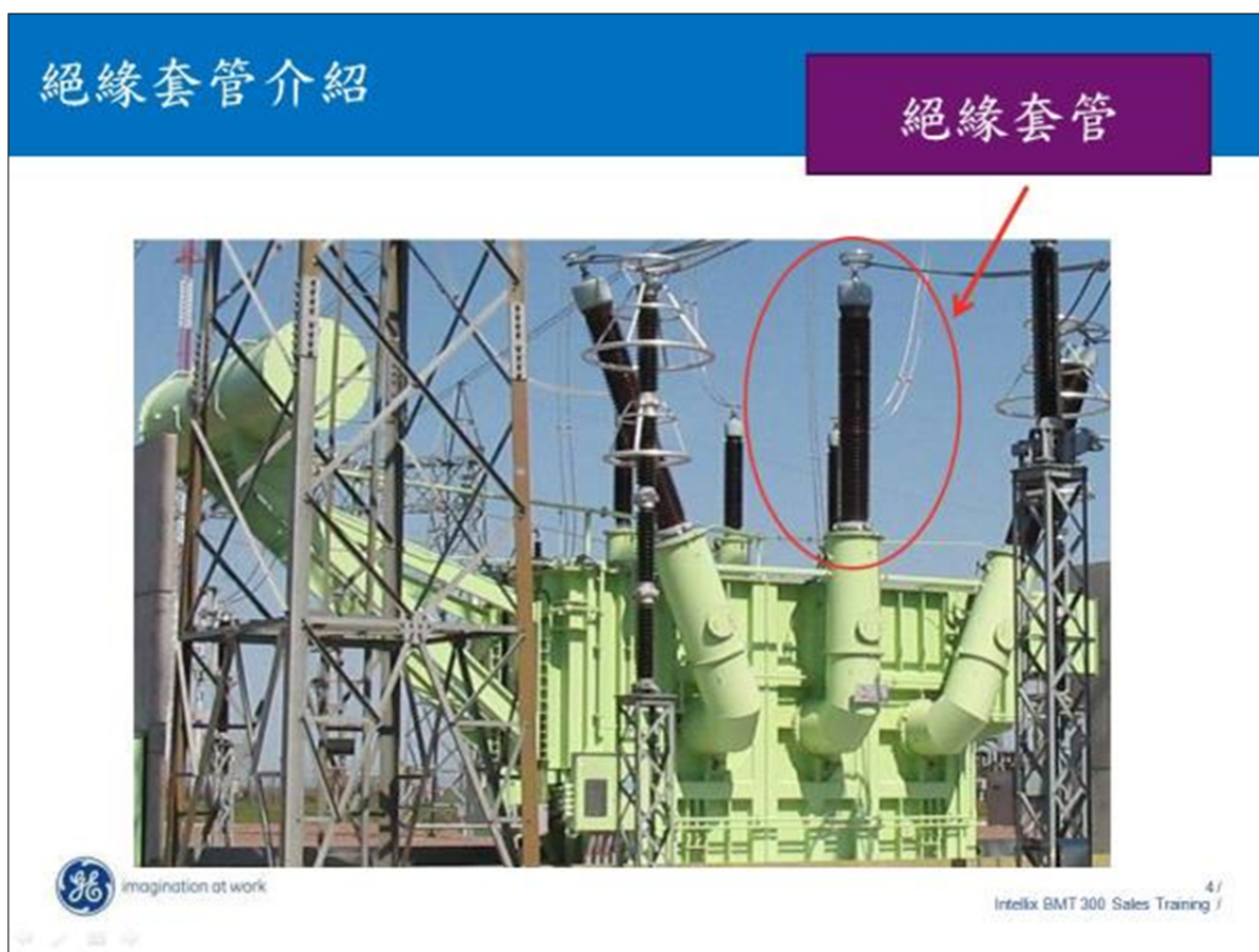
圖 參- 25 變壓器絕緣套管狀態監測/診斷
