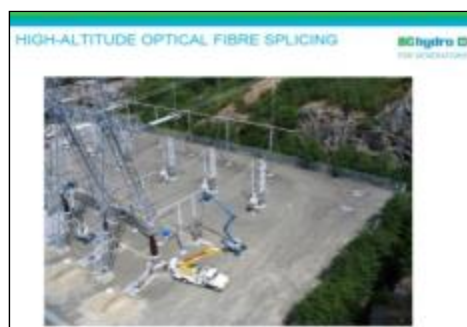
圖 參-15 光纖終端引出裝置
