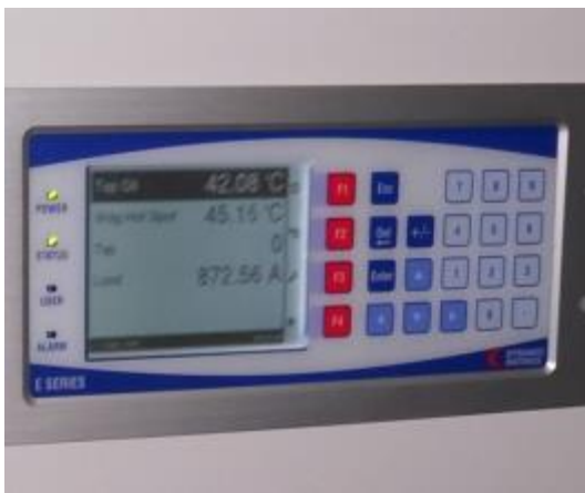
圖 參-46 變電所內線上監測數據/智慧診斷系統運作情形
