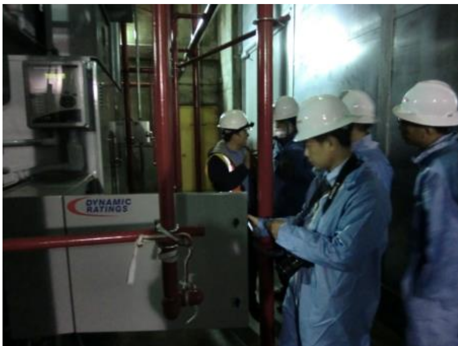
圖 參-47 變壓器狀態監測/診斷系統 Dynamic Ratings
