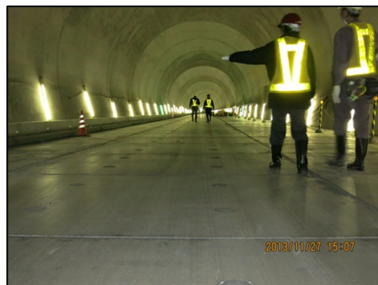
圖 8、二次襯砌與路面基層施作成果
