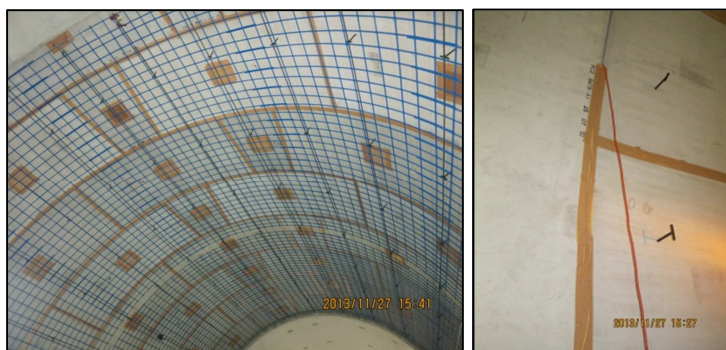
圖 10、二次襯砌鋼筋綁紮，綁紮前於各接縫預埋導流管，預防海水滲漏。
