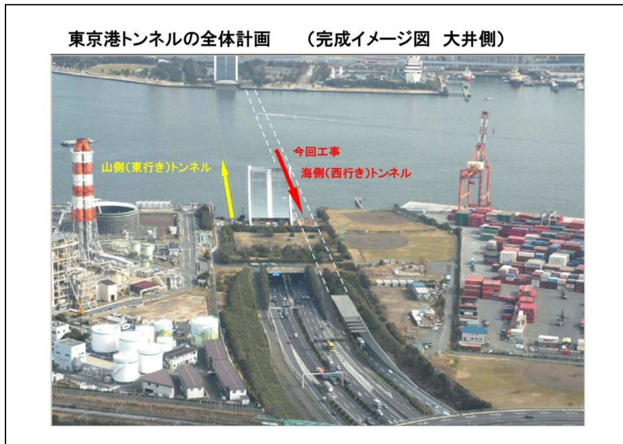
圖 5、東京港隧道工程鳥瞰
