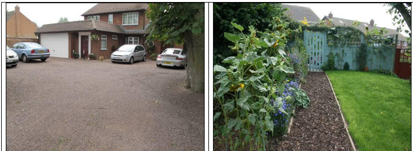
圖 3-5：車道採透水鋪面
