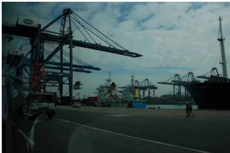
碼頭岸邊吊機作業。
