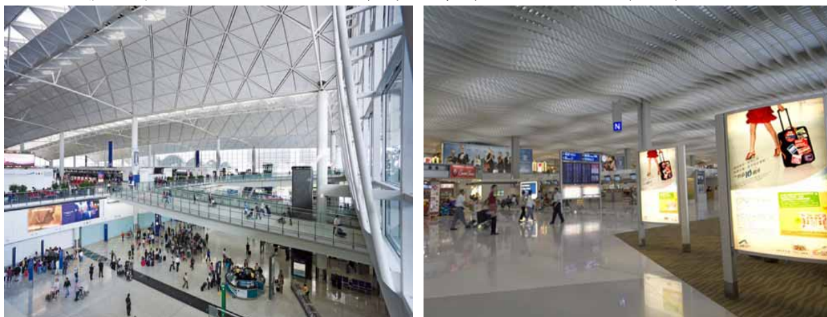
圖 4.32 一、二號客運大樓大廳
