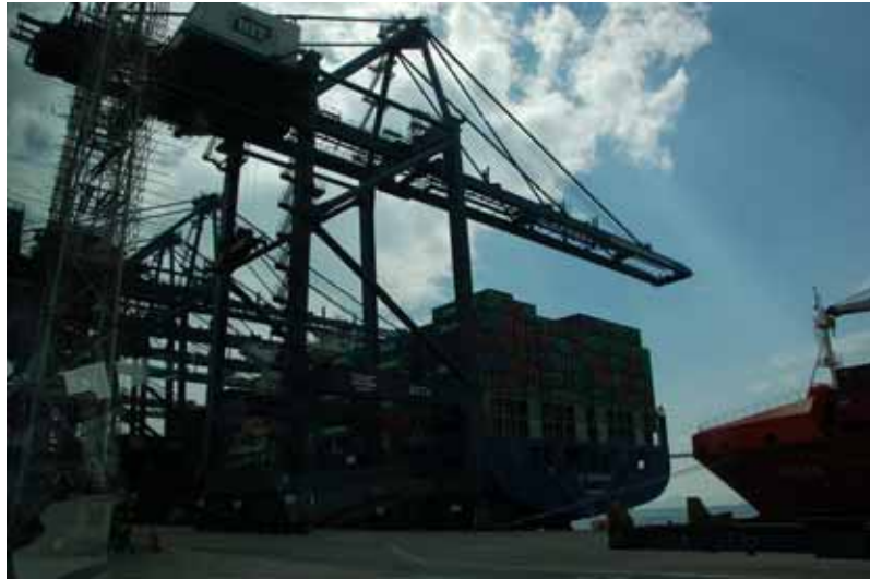
碼頭岸邊吊機作業。
