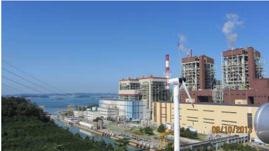
圖 3-26、Boryeong 電廠位於海邊之燃煤機組
