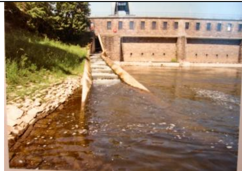
攔河堰右岸舊有魚道，坡度過大，僅有上溯功能，無往下游遷移功能
