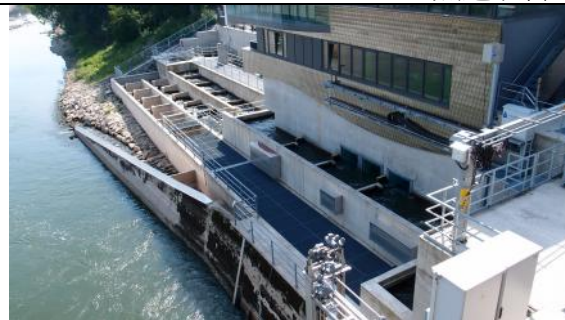
魚道現況全貌，利用舊有魚道擴建，使坡度減緩，並增加往下游遷移功能出口
