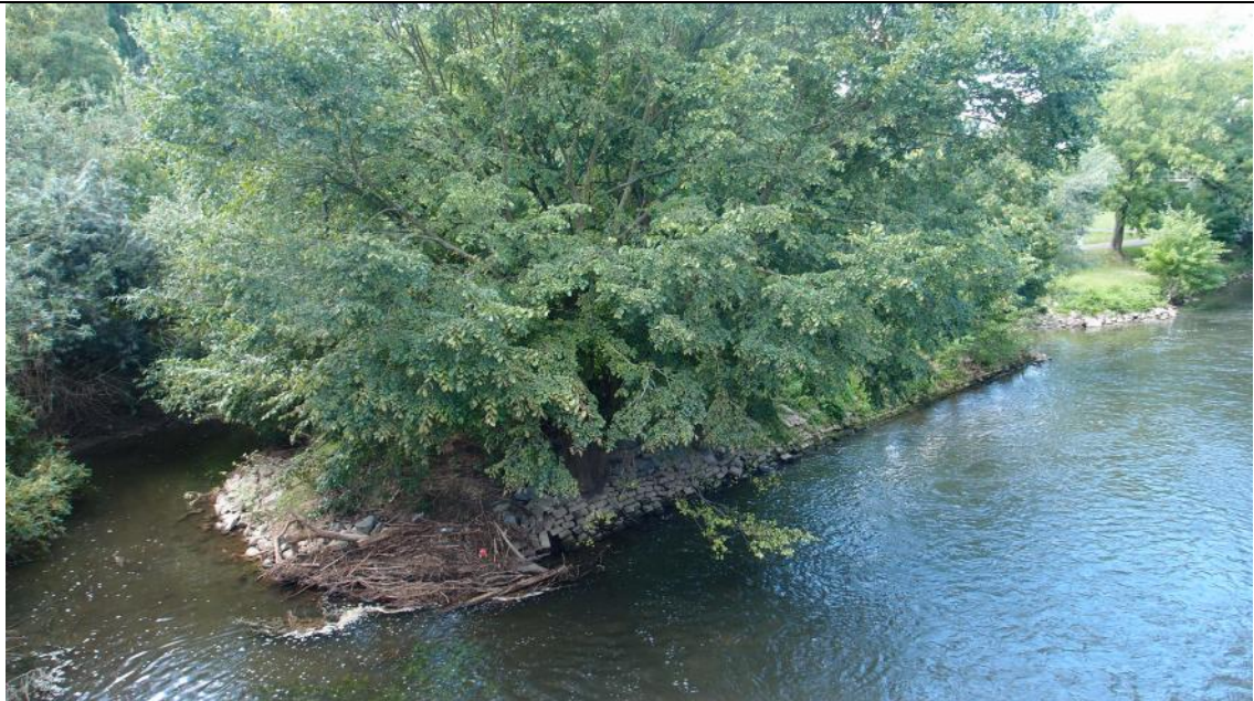
造成河川渠道化之砌石護岸遭局部沖毀後，不予復建，由河川自然蜿蜒發展，原砌石護岸現成爲河中島，植物生長繁密的生態棲地。
