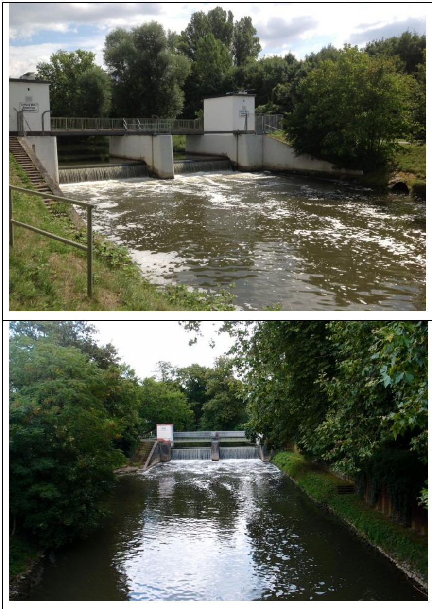
圖 8 尼塔河攔河堰
