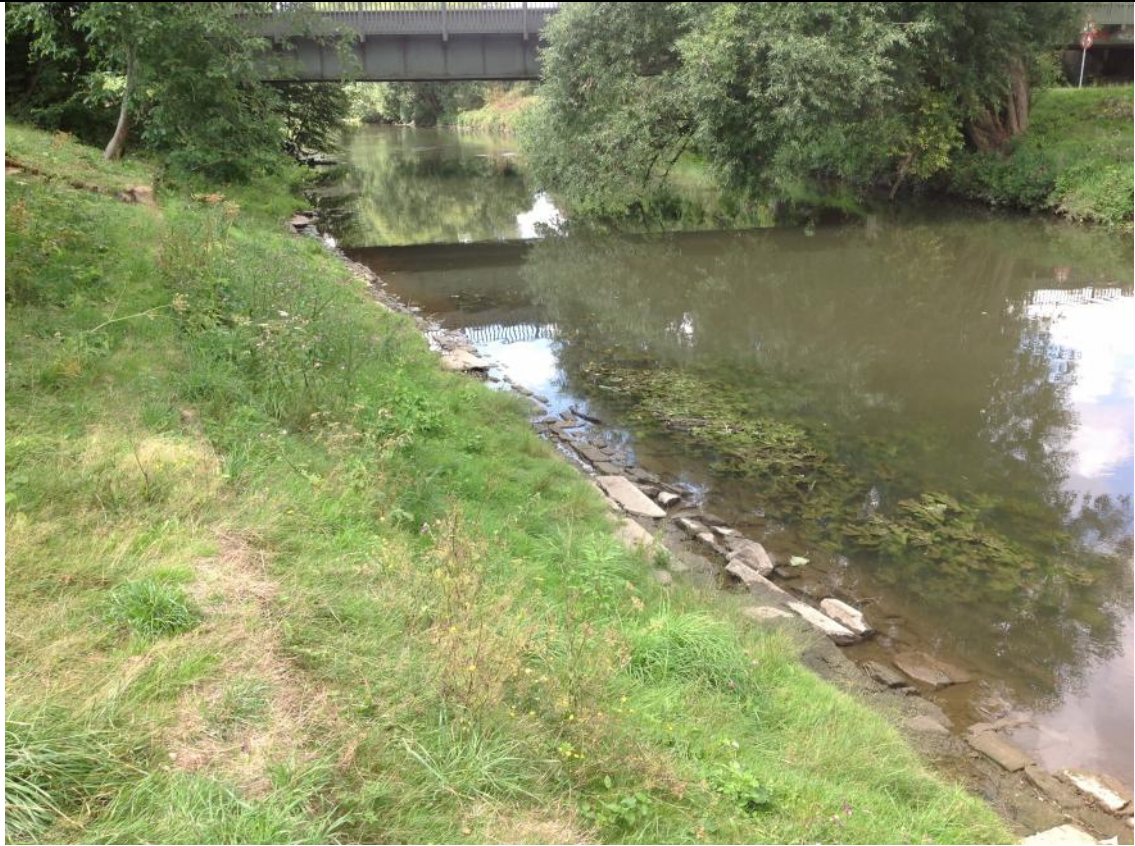
防洪構造以天然石材堆砌，自然融入環境景觀，堤前坡覆厚土層，供植物自然生長
