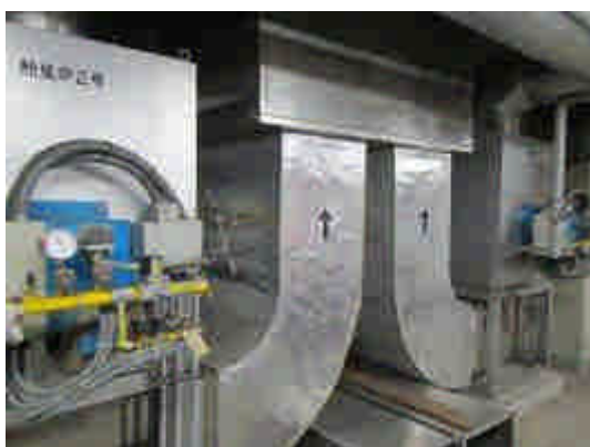
圖 37：救助機動部隊室內搜索空間使用之發煙設備。
