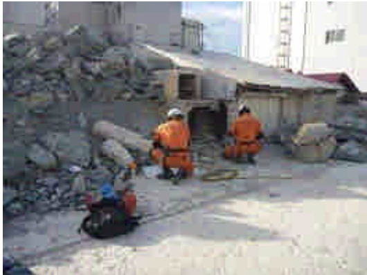
圖 72：救助隊人員以搜索繩準備進入倒塌房屋進行搜索。
