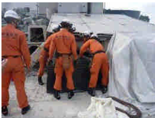
圖 64：覆蓋防爆毯，以確保炸開時不會四散飛射。
