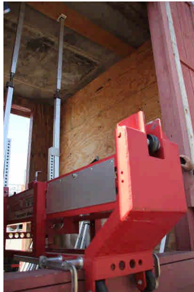
圖 6-15 Hero Pipe 組裝過程
