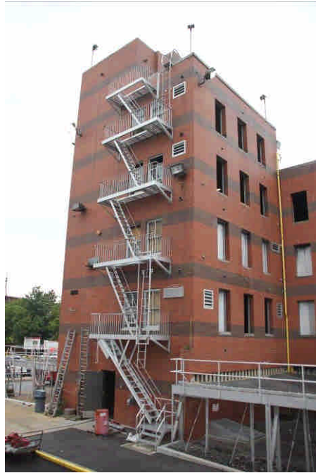
圖 3-5 複合住宅訓練塔外觀
