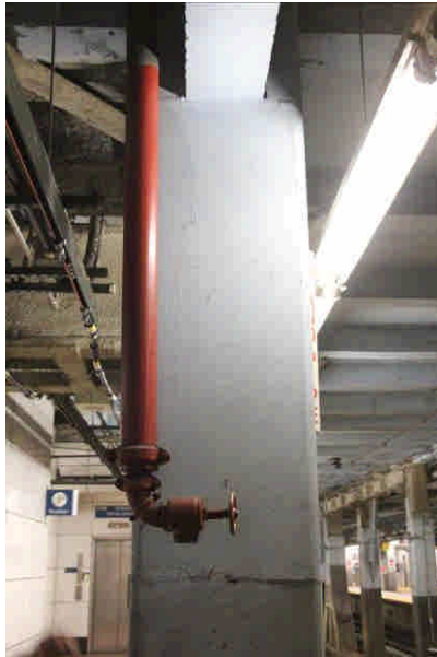
圖 4-11 環狀式設計消防管線
