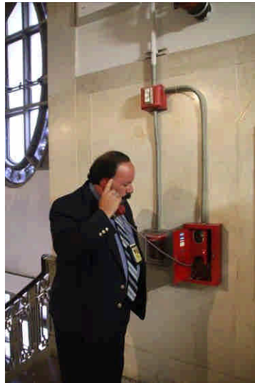
圖 4-3 緊急通報系統
