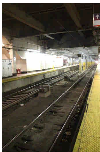
圖 4-10 高架電力系統
