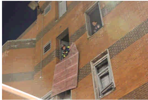
圖 6-18 架設風控設備
