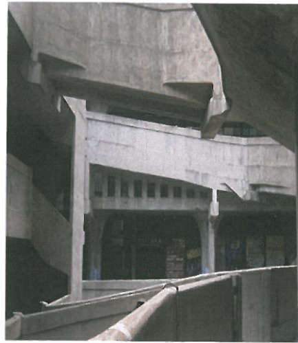
土坡道、廊橋、螺旋梯之特殊建築
