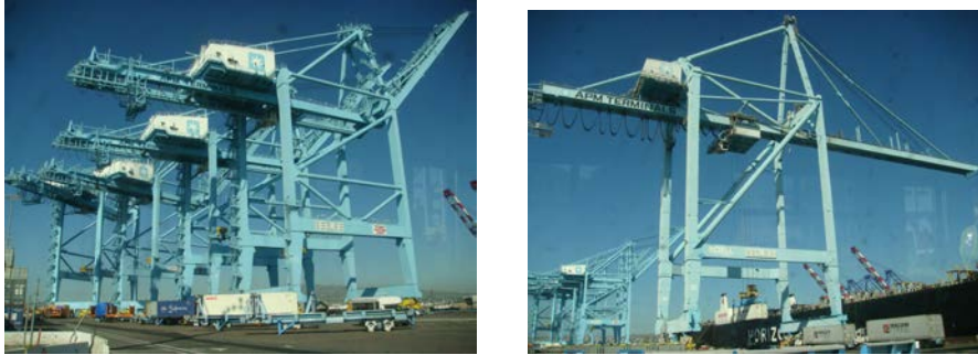
圖 4-13 APM 公司岸邊多座橋式起重機，都已是全面電力化。
