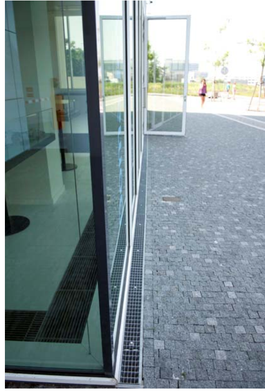
圖 62 戶外雨水截水溝與透水鋪面
