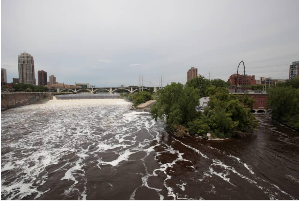
圖 37：聖安東尼瀑布水利設施 右側為水力發電廠，仍然供給本地區產業發展。
