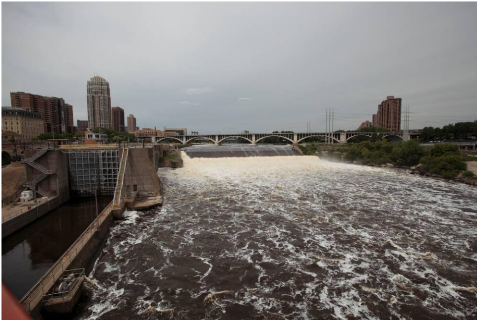
圖 36：聖安東尼瀑布水利設施 左側為水位閘門用於通航
