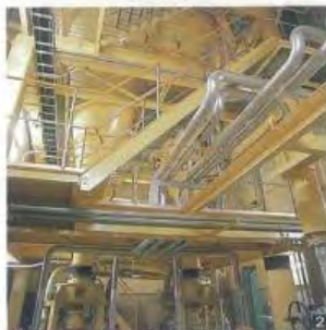
塩化水素除去装置 排ガス中の塩化水素などを除去するための消石灰を貯留、供給します。
