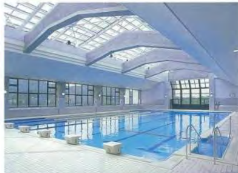
温水プール ごみ焼却工場の余熱を利用した温水プールで、25 mプール(7コース)、幼児用プール、打たせ湯やジャグジー、採暖室などを設けています。
