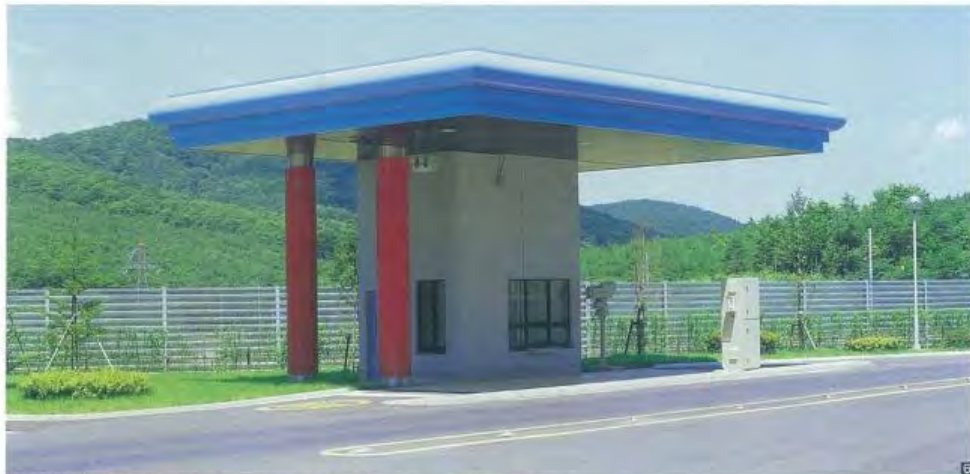
灰計量機 搬出する焼却灰および飛灰の重さをはかり、搬入ごみと同様コンピューターで集計します。
