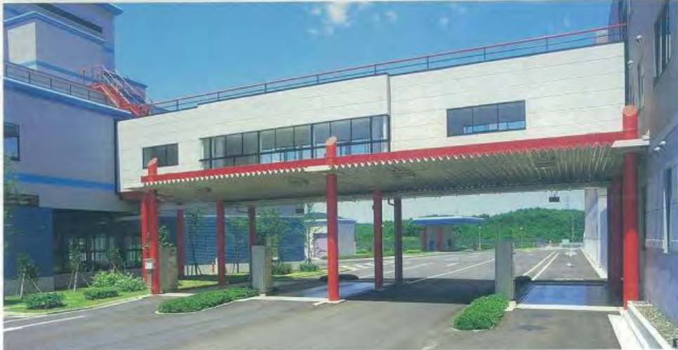
ごみ計量機 搬入されてきたごみの重さをはかり、コンピュータで分類集計して、日報・月報などを作成します。
