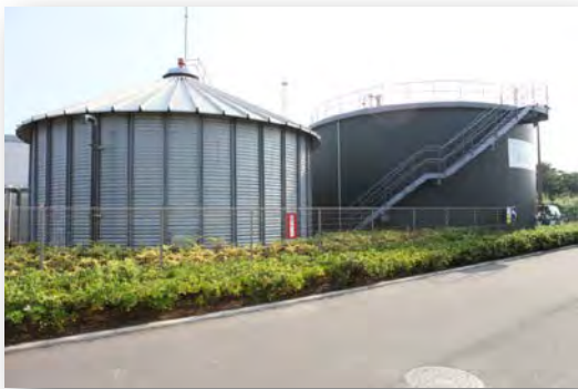
發酵槽&沼氣儲貯槽
