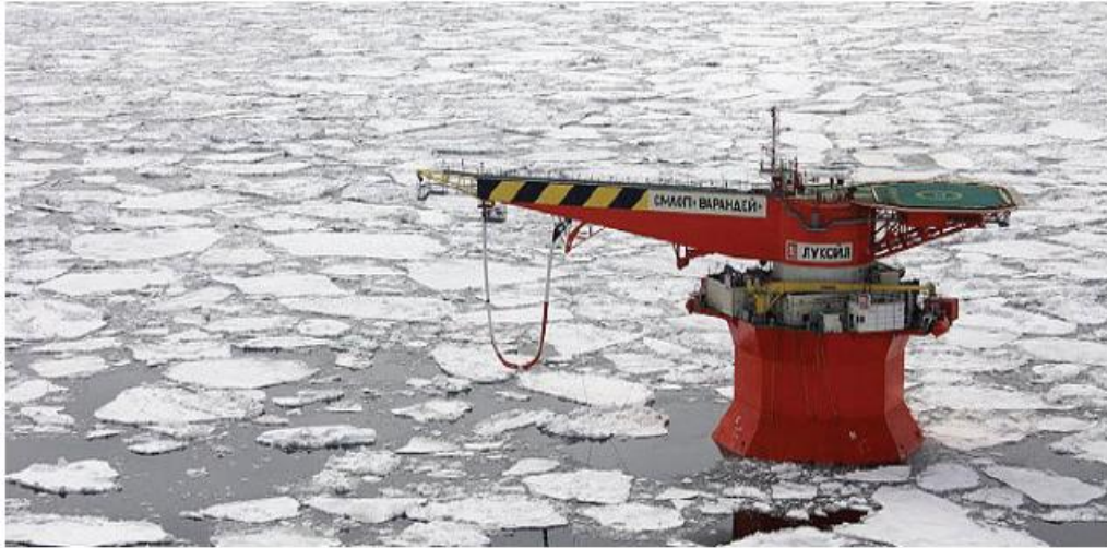
圖 3.46 可抗浮冰的海上輸油兼補給站 “Varandei”
