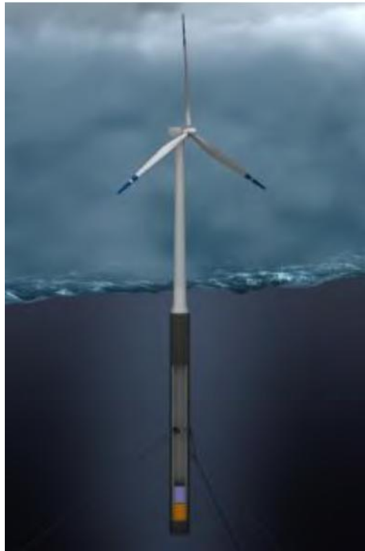
圖 3.29 OC3-Hywind spar buoy
