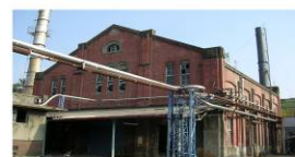
图4, 台中文创园区-B07 (历史建筑) 锅炉室。原为锅炉室, 为砖造维多利亚式建筑物, 立面造型精美, 建于1928年, 为酒厂动力来源。现经原貌样保存, 为酒文化馆重要生命史展示功能, 视为园区指標建筑。
