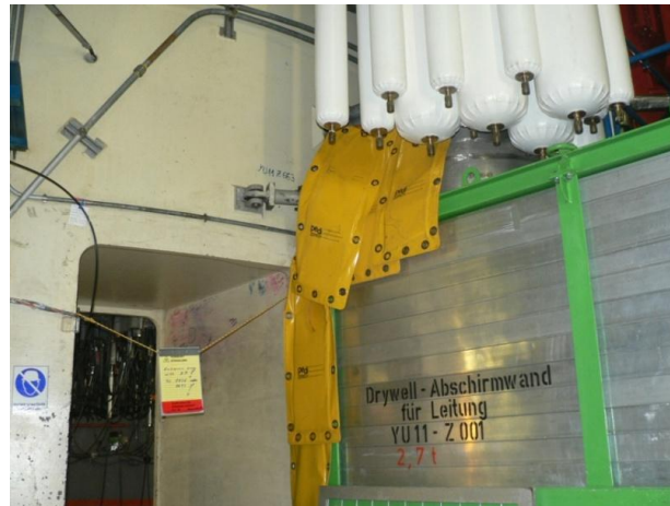
圖八、瑞士核電廠乾井一樓 Under vessel 門口之臨時式與固定式屏蔽
