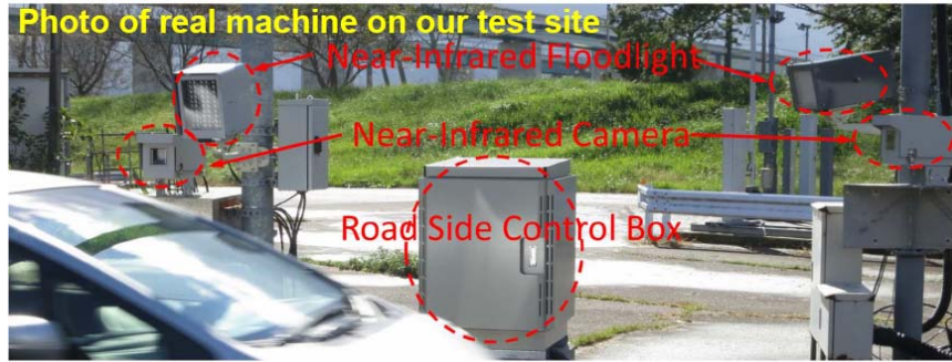
車內乘客辨識系統設備
