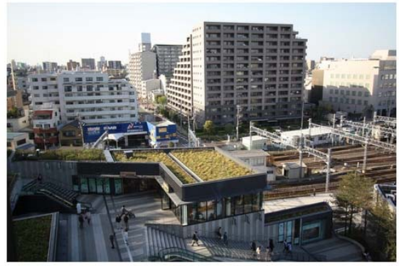
照片 1-17 說明：屋頂植栽綠化
