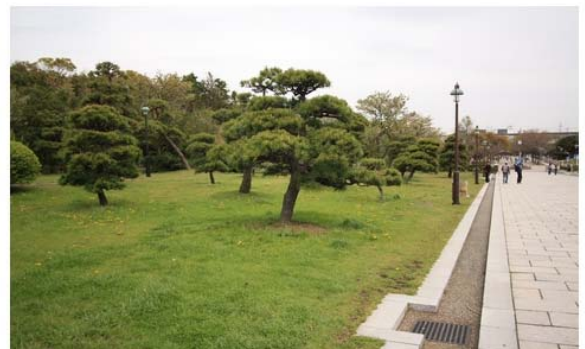
照片 a06 步道側排水淺溝 (少溝蓋、易清理)
