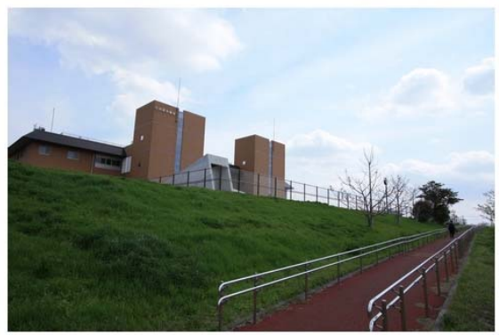
照片 3-05 說明：管理處入口無障礙設施
