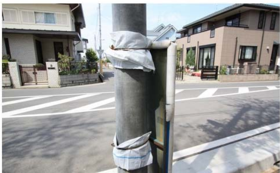
照片 a16 施工告示牌固定於路燈桿
