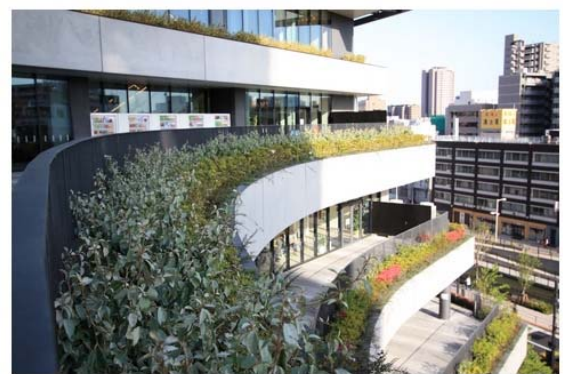
照片 1-14 說明：建物牆面採階梯式設計，並以植栽綠化
