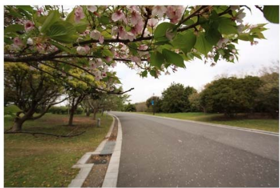
照片 5-18 說明：簡易鋪面排水邊溝（未加蓋淺溝），便於清潔維護
