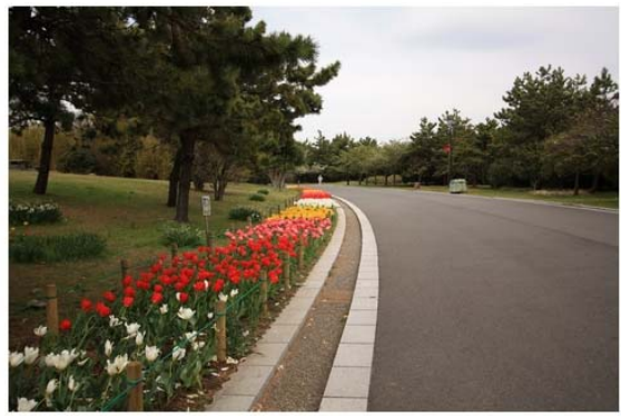
照片 5-17 說明：簡易鋪面排水邊溝（未加蓋淺溝），路側栽植鬱金香，採簡易低矮圍籬區隔
