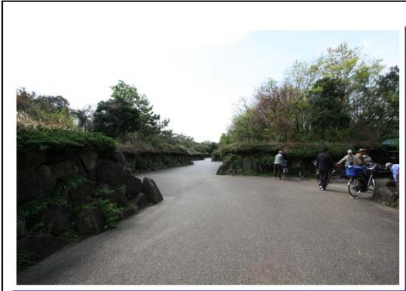
照片 5-12 說明：鳥園中央步道～兩側採砌石及植栽綠化方式，區隔溼地為上下二池
