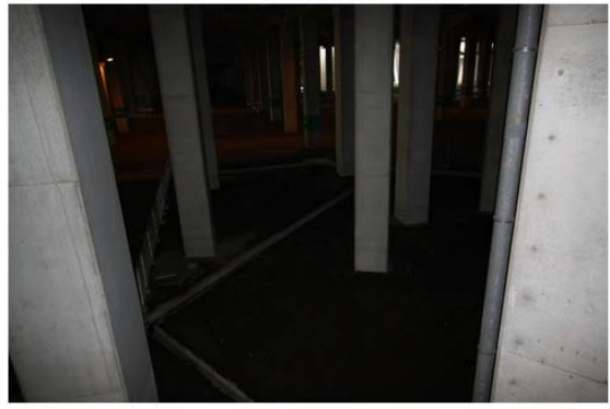
照片 2-03 說明：體育館場下方滯洪空間，平日供停車使用
