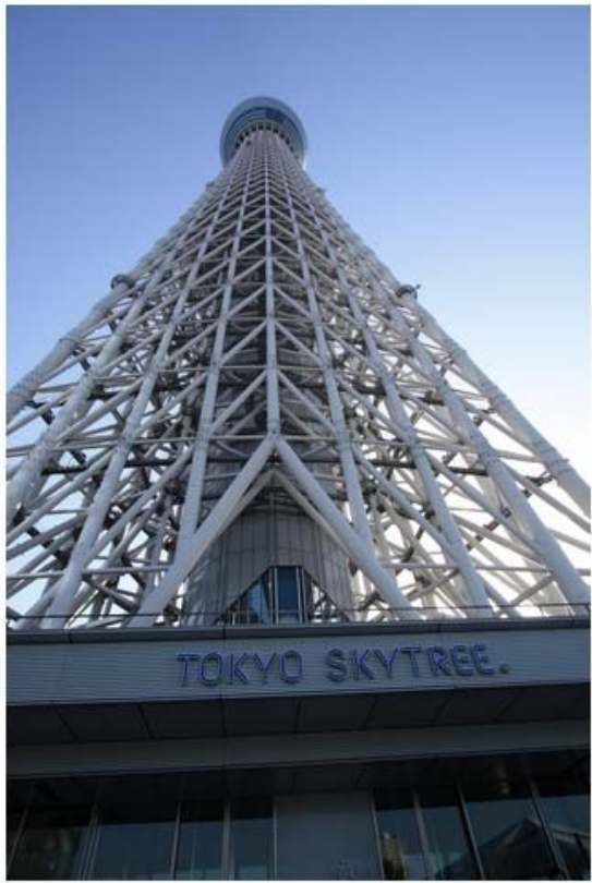
照片 1-15 說明：自屋頂廣場仰望
