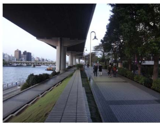
照片 4-05 說明：隅田川（左岸）～超級堤防第一階堤頂
