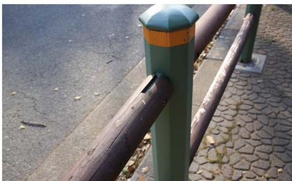
照片 a11 金屬立柱搭配木造橫擋的阻隔圍欄
