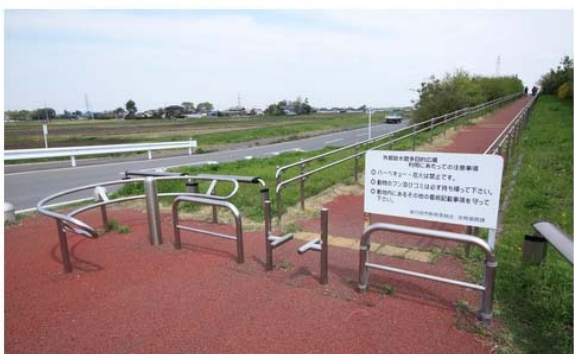
照片 a18 不鏽鋼車阻擋
