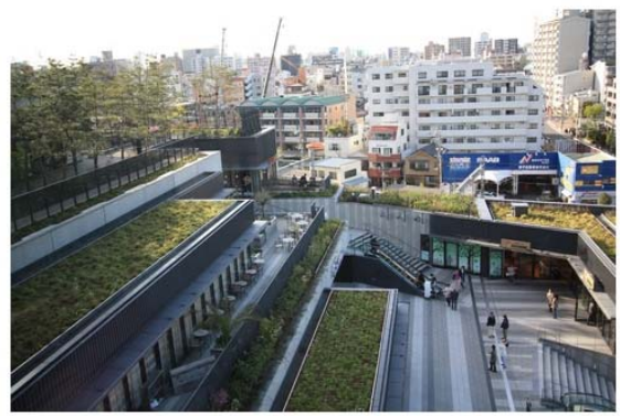
照片 1-18 說明：屋頂植栽綠化
