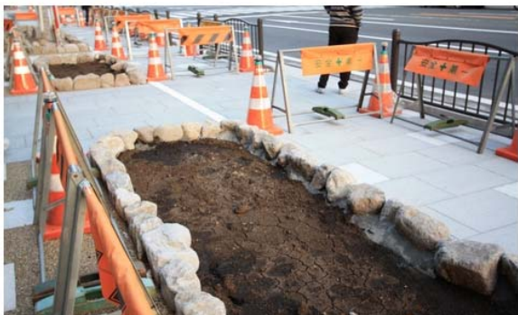
照片 a02 植栽帶沃土回填 (無石塊、雜物)
