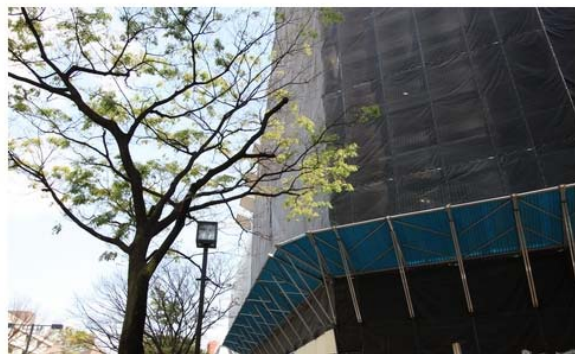
照片 a20 建築施工防護
