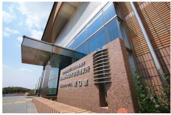
照片 3-08 說明：管理單位～國土交通省江戶川河川事務所首 都圏外郭放水路管理支所
