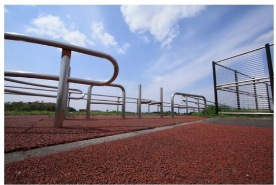
照片 3-06 說明：無障礙設施終點～圓弧轉折入口設計（可阻礙機動車輛進入）
