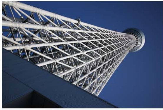
照片 1-09 說明：塔外部桁架
