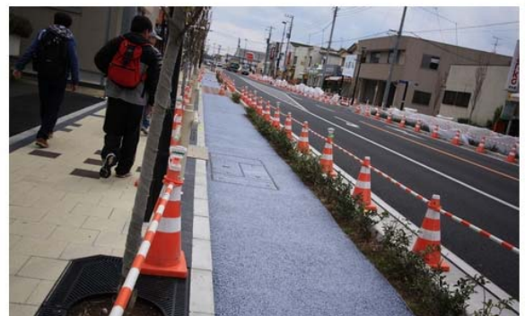
照片 a14 回程：答案揭曉，彩色鋪面施工
