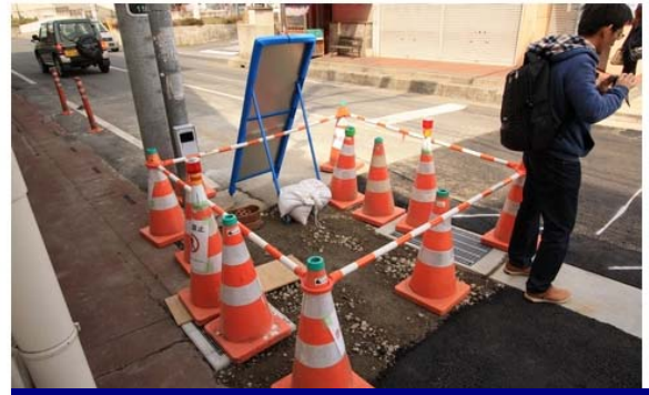
照片 a12 一小塊施工範圍圍了很多個三角錐
