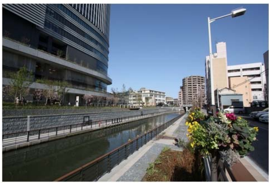
照片 1-02 說明：塔下鄰近排水設施
