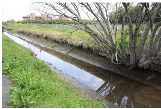
照片 3-02 說明：農用水路～簡易土溝型態
