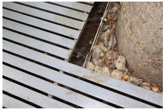
照片 7-07 說明：櫟樹球根可見束帶，猜測應為地下隱形支架
