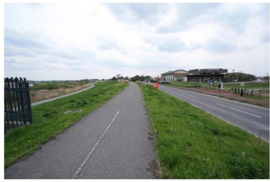
照片 3-11 說明：抽水站外江戶川堤防，堤內(照片右)採緩 坡、類超級堤防方式設計
