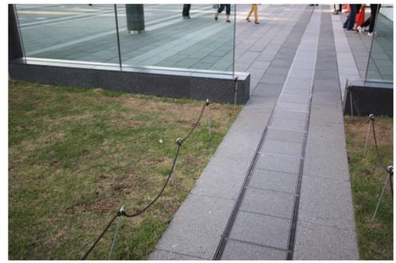
照片 1-13 說明：屋頂草皮簡易圍設，步道下方為屋頂截留水路，匯集屋頂廣場排水
