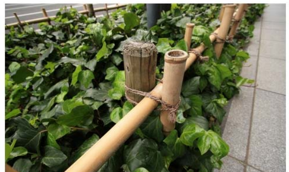
照片 a07 竹子、木柱、麻繩搭配成簡易圍籬
