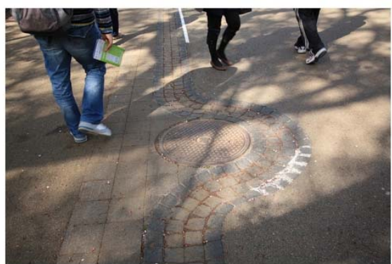
照片 6-11 說明：步道鋪面排水淺溝(與電力人孔介面之處置)
