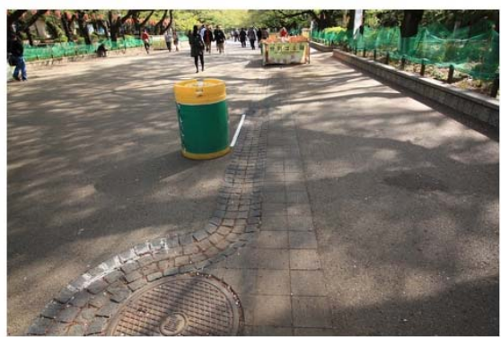
照片 6-10 說明：步道鋪面排水淺溝
