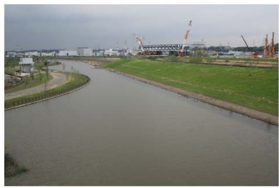
照片 2-11 說明：滯洪池內水路，設計為寬闊帶狀水池，平日吸引水鳥棲息
