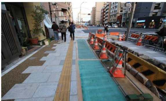
照片 a03 施工區外圍鄰近界面鋪設塑膠墊保護
