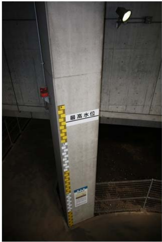
照片 2-04 說明：館場下方洪氾期間可滯納洪水高度達近 5 公尺，平日規劃作停車使用。
