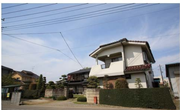
照片 a17 與混凝土牆銜接一體的植栽綠籬
