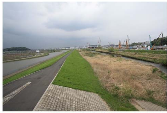
照片 2-10 說明：滯洪池內、外水路區隔（溢洪堰）
