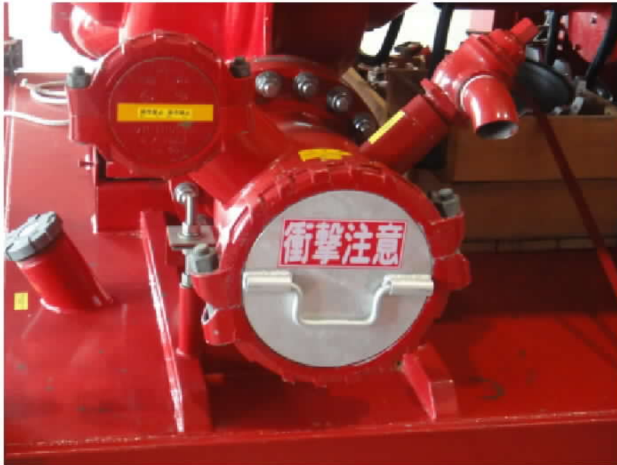
圖 5-9、送水幫浦出水口（12 英吋）
