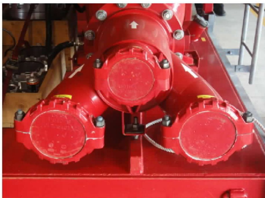
圖 5-8、送水幫浦進水口（8 英吋）
