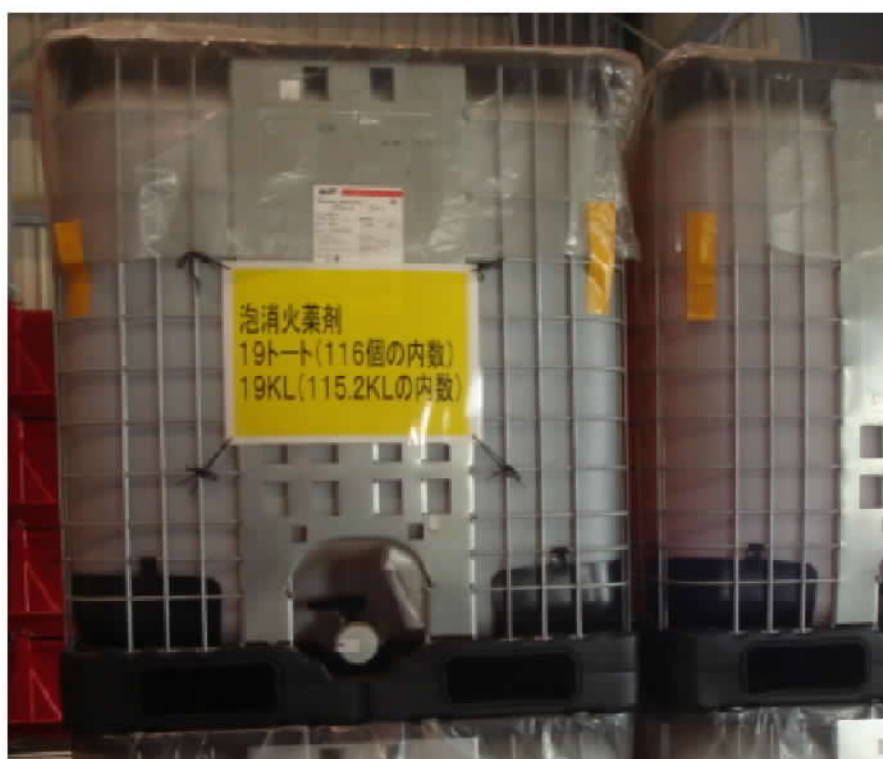
圖 5-15、泡沫滅火藥劑（原液）容器
