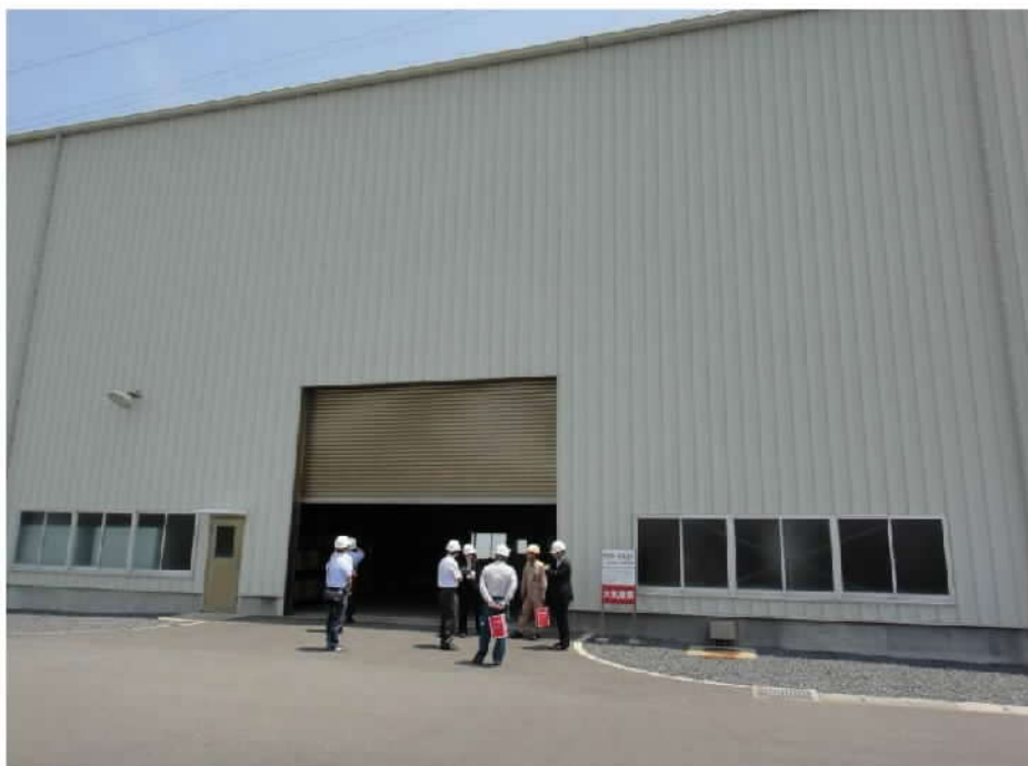
圖 5-1、放置大容量泡沫放射系統機具設備之倉庫
