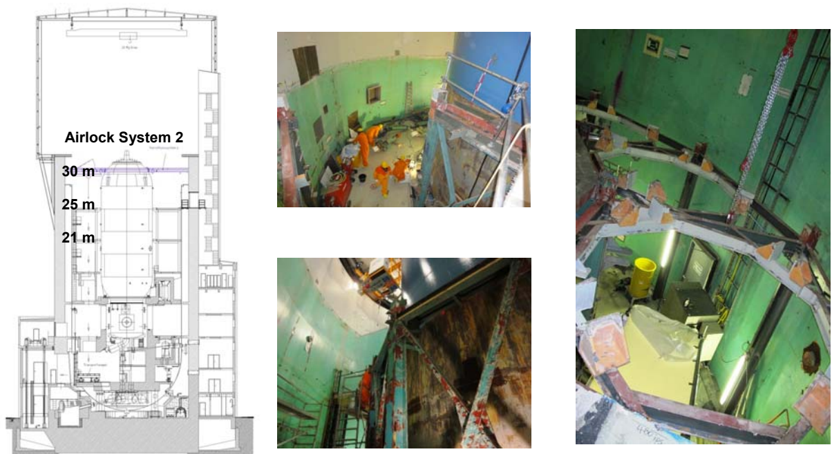
圖 2、工作平台的拆除作業
