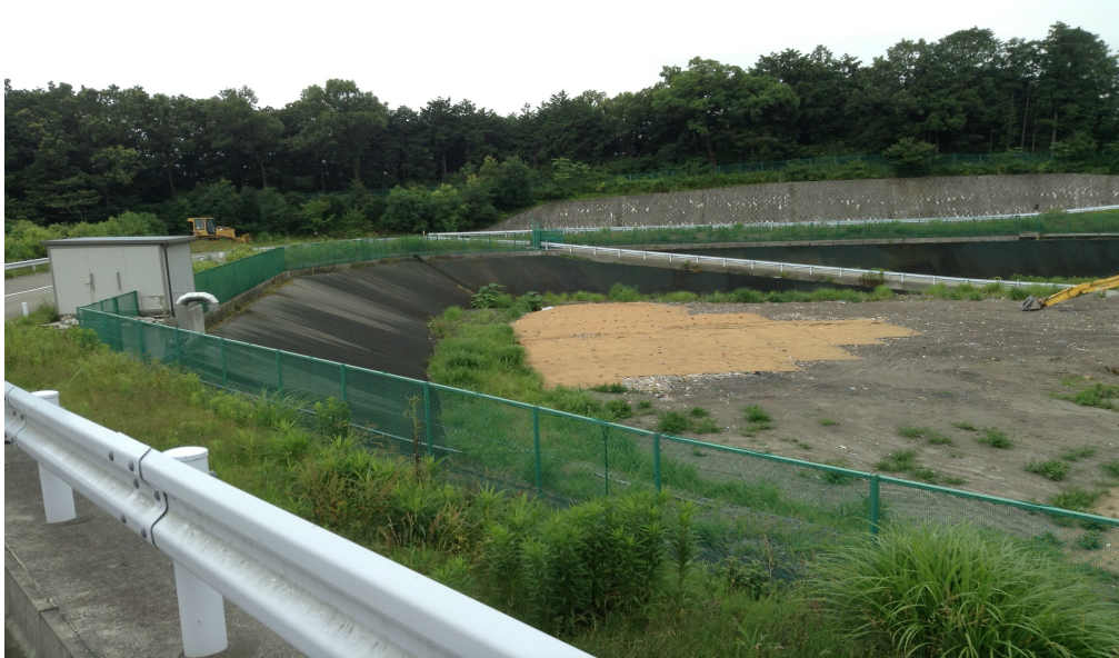
圖表 14、長泉町最終處分場作業實景 4.不燃廢棄物掩埋
