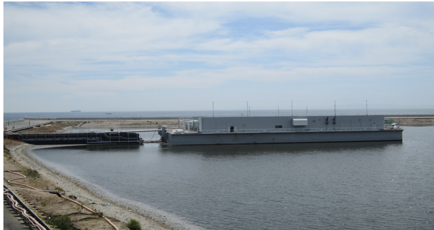
圖表 7、大阪沖埋立處分場浮動式污水處理設備
