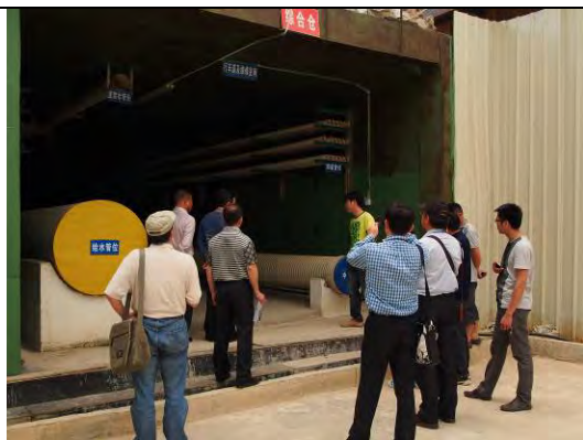
興建中的地下共同管溝工程/李俊延攝
