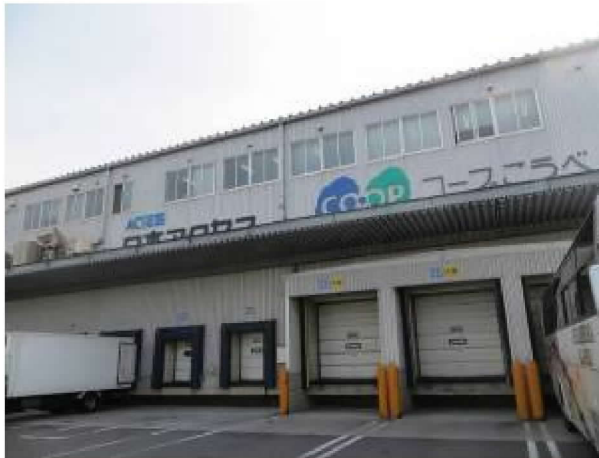
日本 ACCESS COOP 神戶鳴尾浜低溫物流中心外觀
