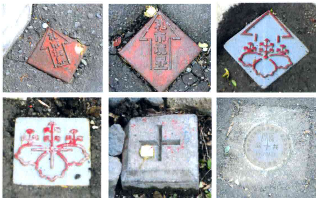
圖 4-1 日本札幌法務局南出張所附近實地界標埋設樣式
