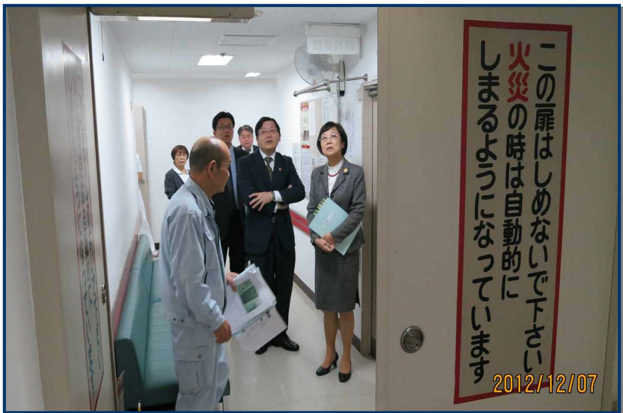
照片 11-6、本院尹委員實地訪查大鵬會千本醫院防火區劃與防火牆裝置及運作
