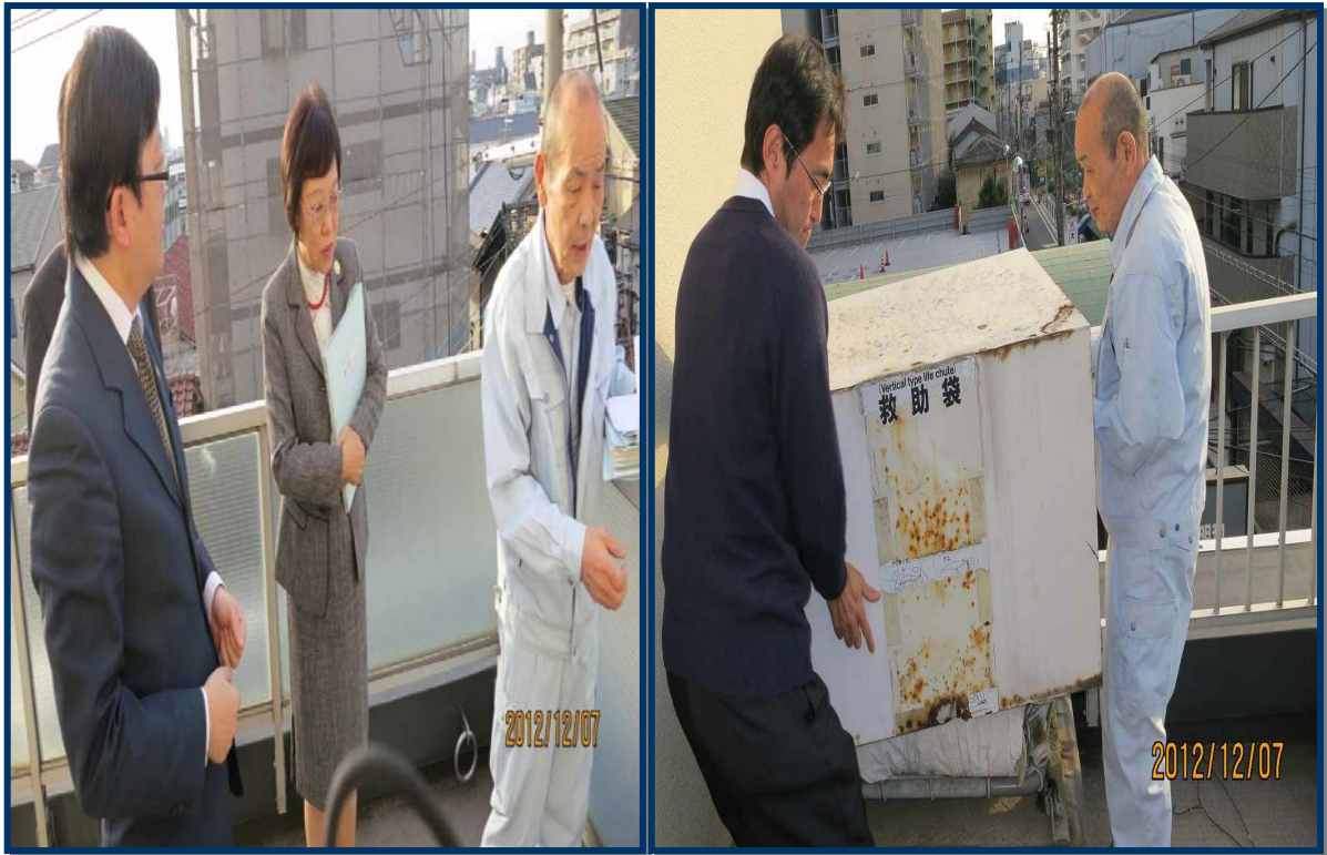
照片 11-4、大鵬會千本醫院技術人員為本院尹委員示範操作逃生設備
