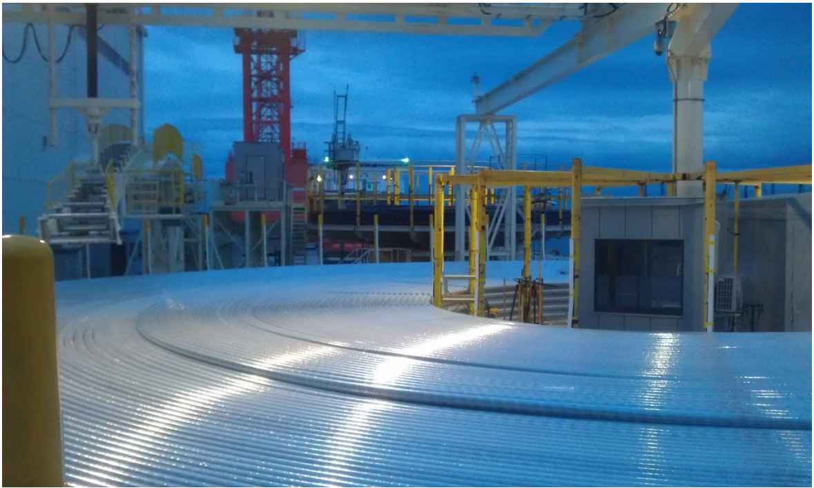
照片 16:第一條海纜接續完成 PE 押出型墊層後之光纖單元繞捲製程之轉盤引取情形 (背後即為本海纜之輸出港口之及裝吊設備)
