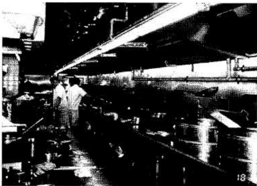
< 典型的運水煙罩及空氣清洗器
