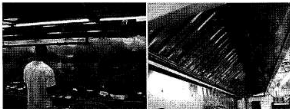
圖 3.5-2 廚房上方安裝「運水煙罩」防制設備
