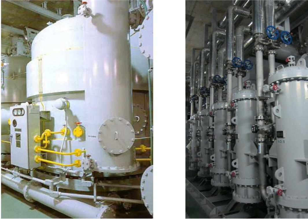
圖 6 PFC 液與 SF6 絕緣之 275kV 變壓器 (左圖) 及 PFC 液與水之熱交換器 (右圖)
