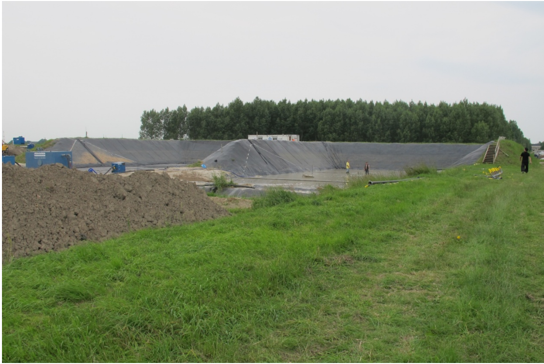
圖 3 East and west dikes 前視照片
