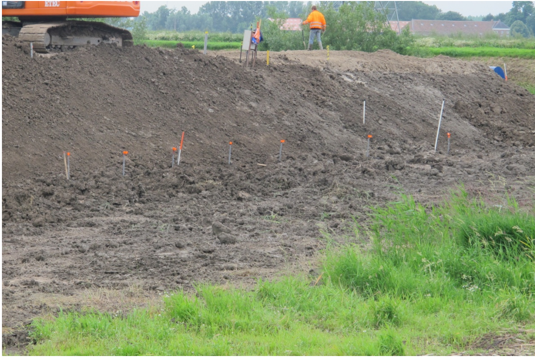
圖 11 South dike 光纖感測器安裝完成(二)
