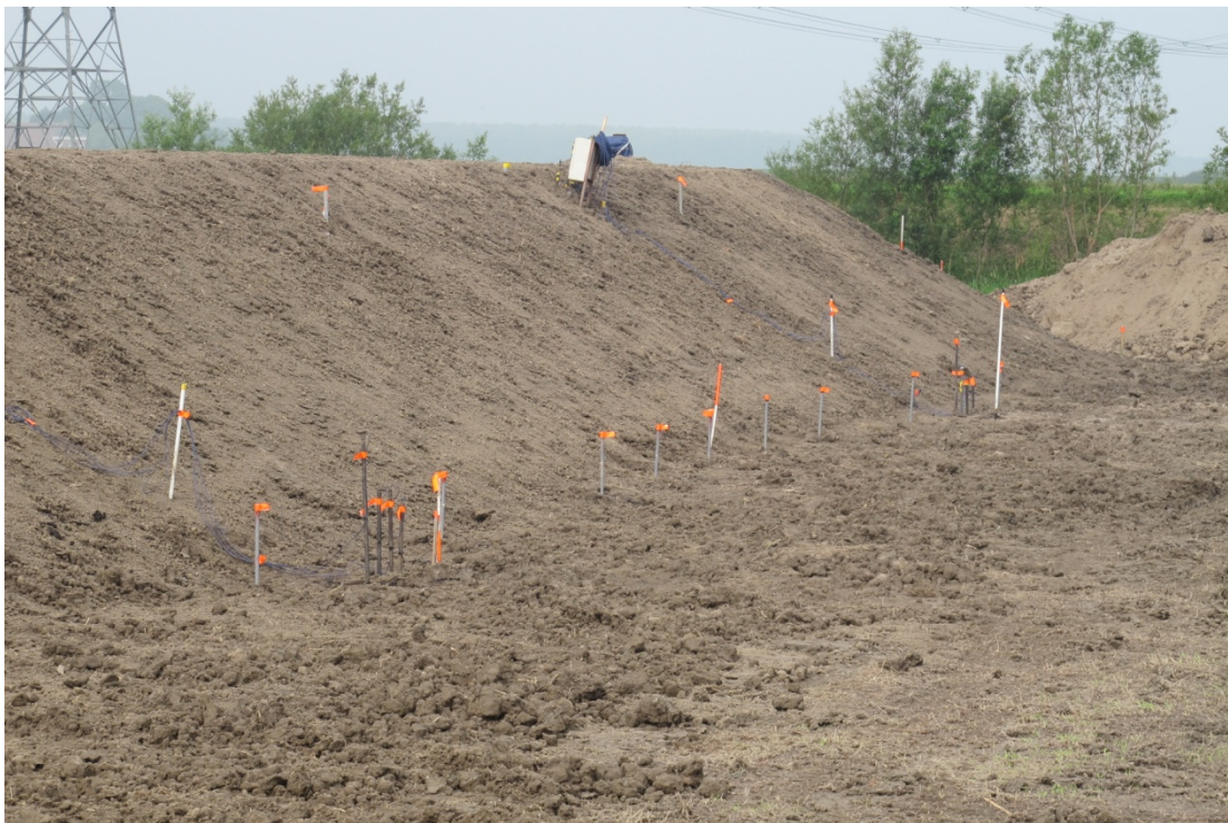
圖 12 South dike 光纖感測器安裝完成(三)
