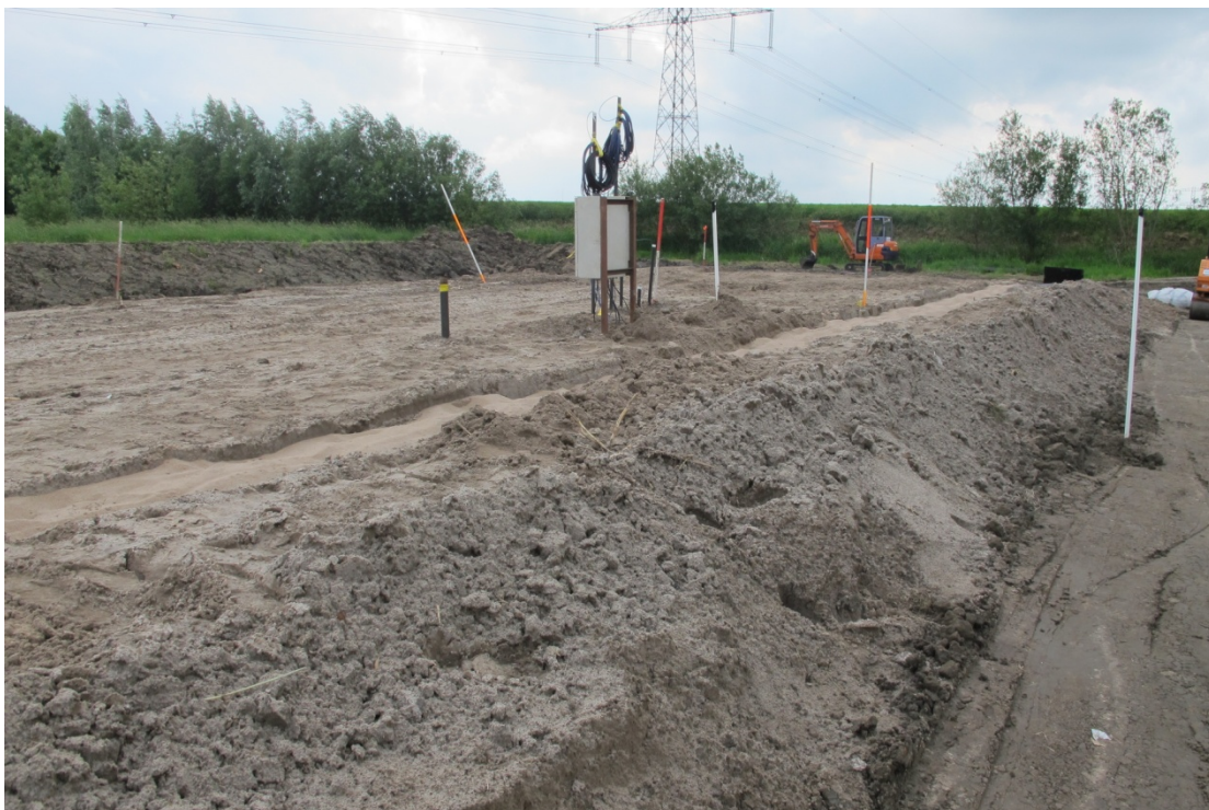
圖 4 South dike 施工前整地照片
