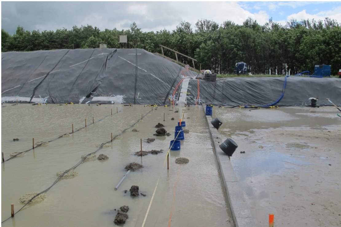
圖 15 East dike 10 米光纖感測器安裝完成(一)
