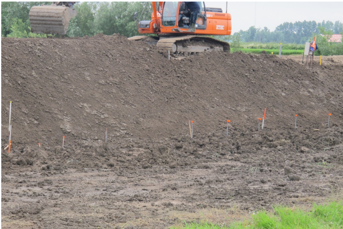
圖 10 South dike 光纖感測器安裝完成(一)
