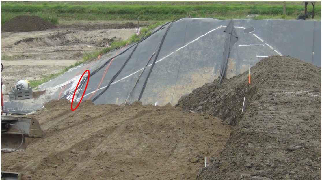
圖 19 第三支感測器安裝完成於 West dike(如圖左方白色不織布右邊的 PVC 管)
