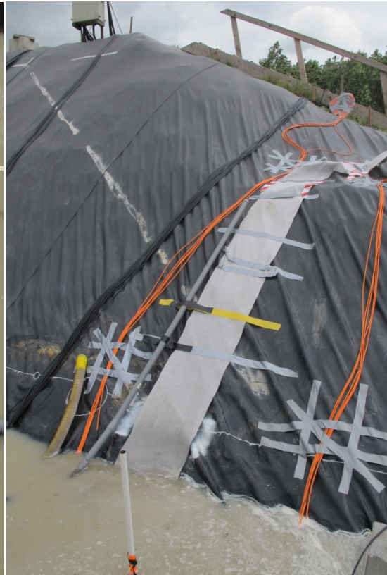
圖 15 East dike 光纖感測器安裝完成(二) 圖 16 East dike 光纖感測器安裝完成(三) (光纖感測器位於圖中 PVC 管內) (光纖感測器位於圖中 PVC 管內)
