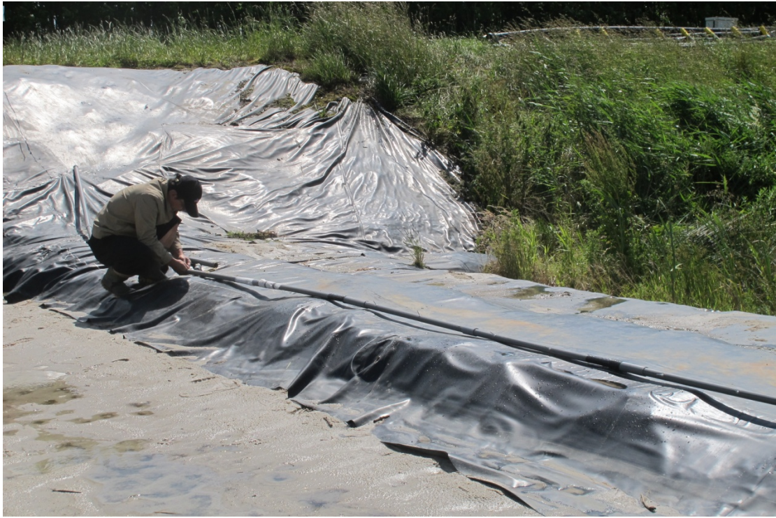
圖 14 East dike 10 米光纖感測器微調作業
