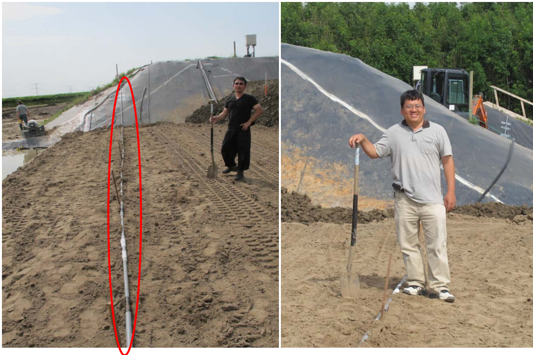
圖 20 與圖 21 第四支感測器安裝完成於 West dike
