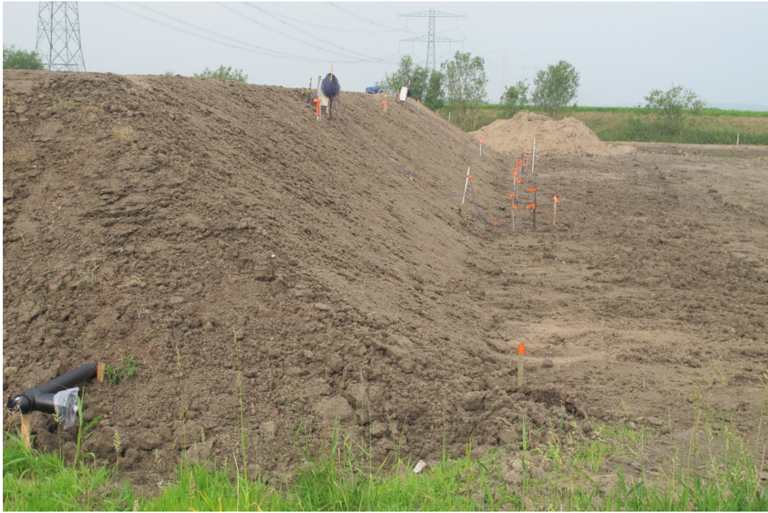
圖 13 South dike 光纖感測器安裝完成(四)
