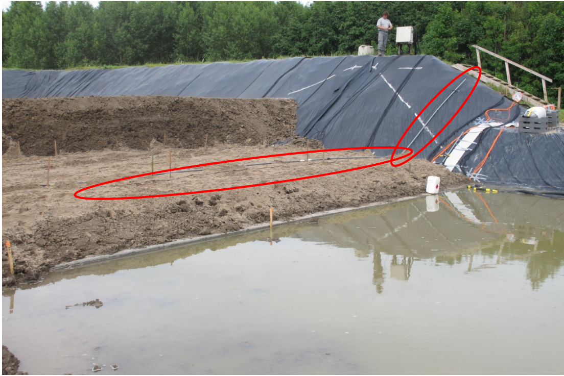
圖 18 East dike 第二支感測器安裝完成(一)
