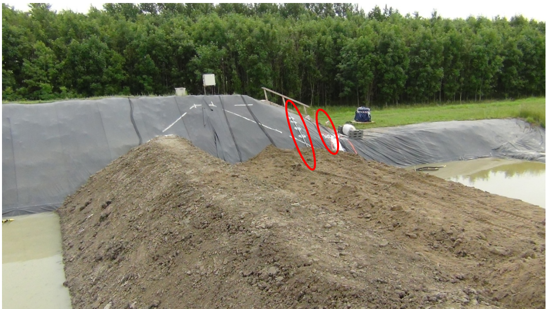
圖 19 East dike 第二支感測器安裝完成(二)
