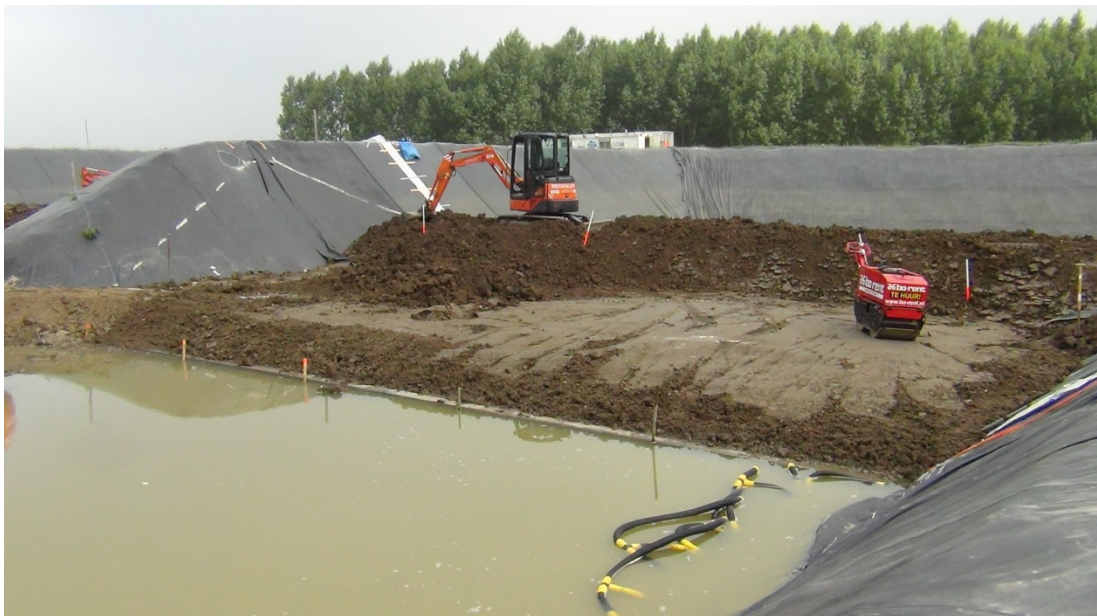
圖 17 East dike 黏土層施工(第一支感測器位於黏土層下方)
