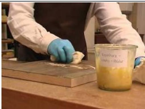
保護層的可選擇可使蟲膠或蠟(如蜜蠟、棕櫚蠟與微晶蠟)，在上保護層之前，若是有一些較大的孔隙，可使用木粉+膠所作的填料填平，待乾後以砂紙磨平。
