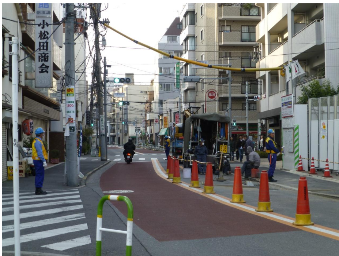
圖十三：簡單道路施工，交通引導指揮就有五人
