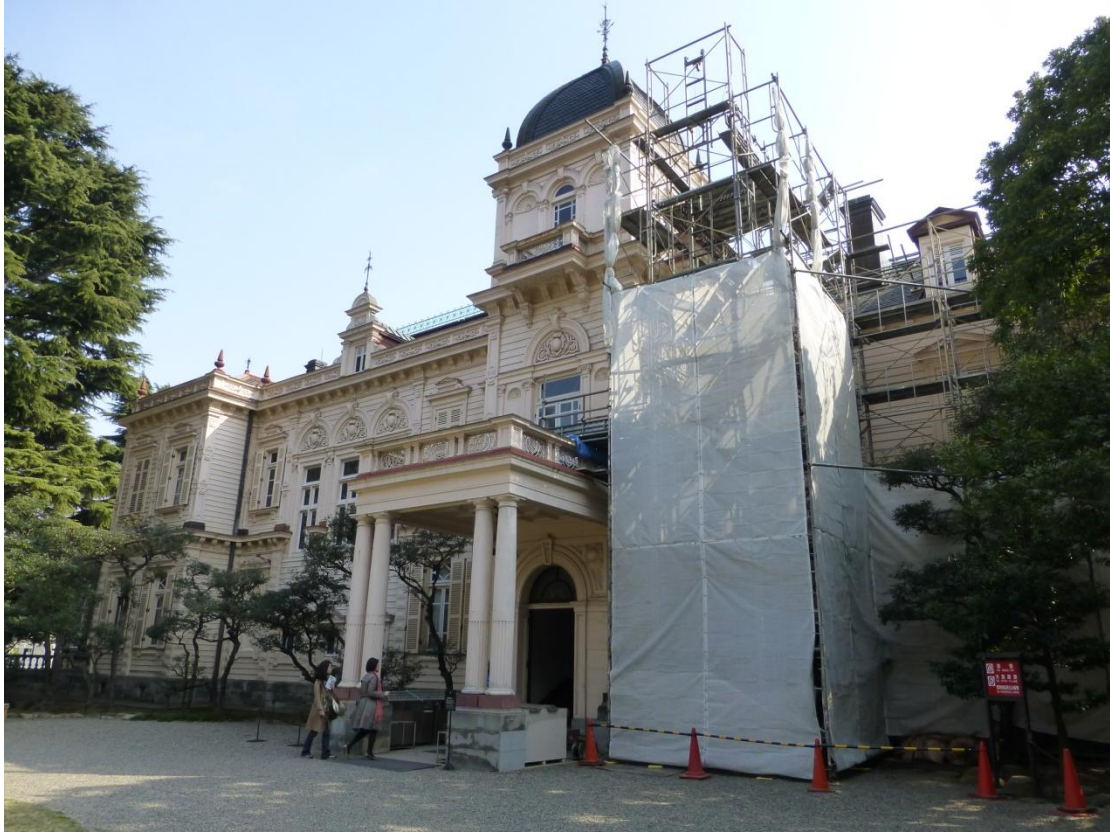
圖十：整修中的重要有形文化財-舊岩崎邸庭園
