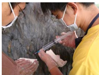
矽酸鹽類填縫及加固(月形石柱) 空心微珠填縫(月形石柱)
