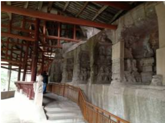
圖：北山石窟 1952 年所搭建的保護棚架
