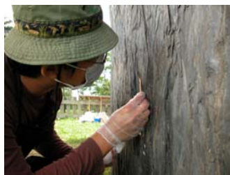
矽酸鹽類填縫及加固(月形石柱) 空心微珠填縫(月形石柱)
