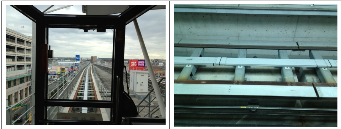
圖 5.12 Linimo 軌道佈設
