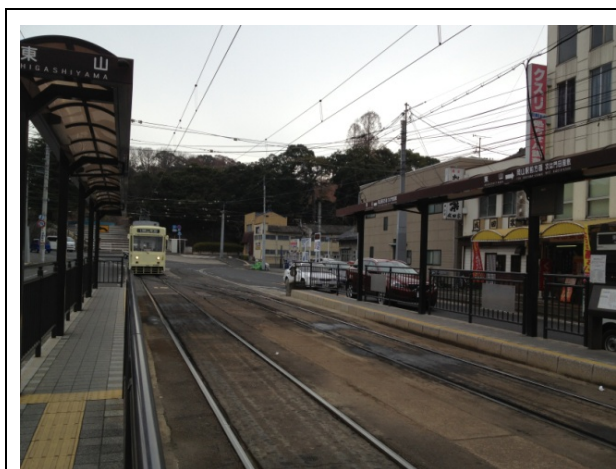
圖 6.6 岡山輕軌軌道佈設
