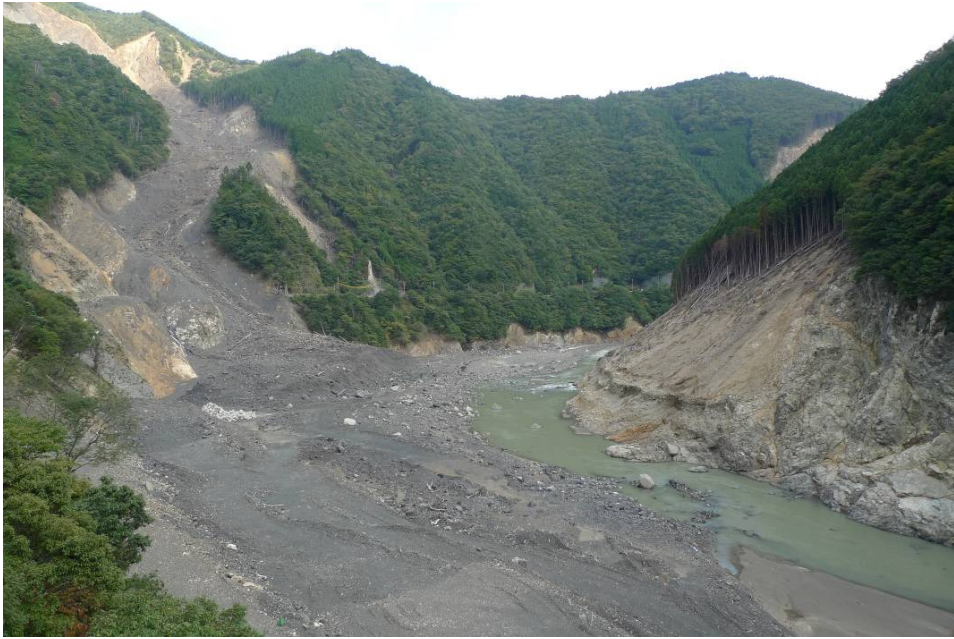
照片四、集水區上游土石崩落現況
