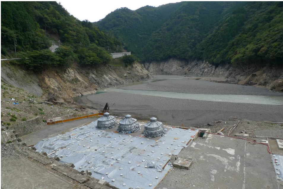
照片五、變電所重建現況
