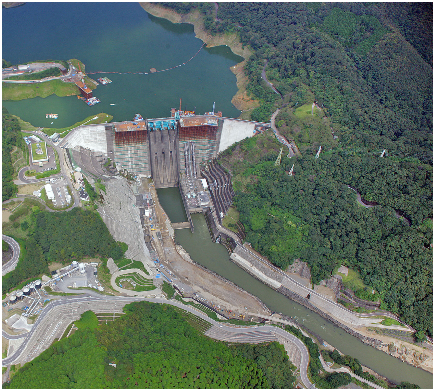
圖十七、下游面構台假設工程(二)
