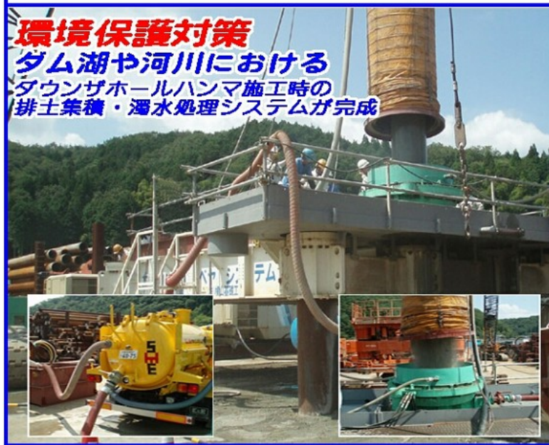
写真-3.架設概念図と排土集積濁水処理システム
