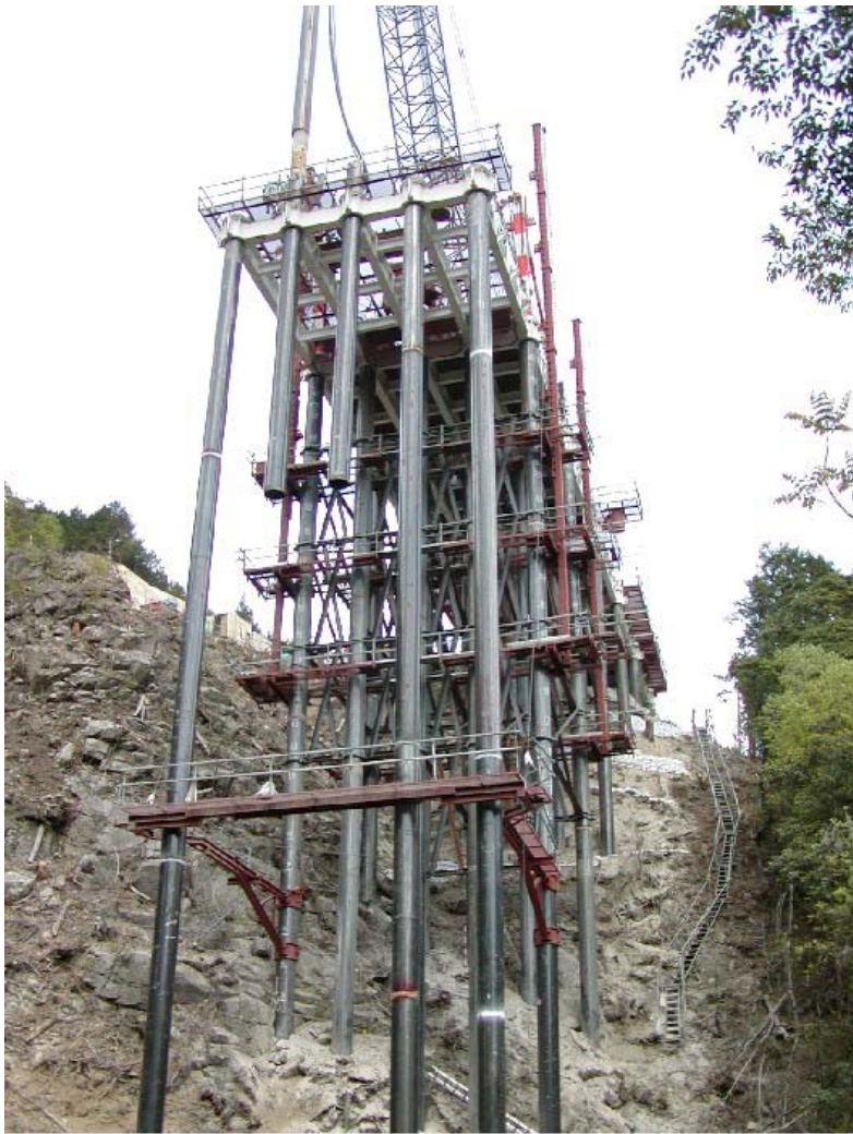
写真-1.鋼管杭打設作業状況
