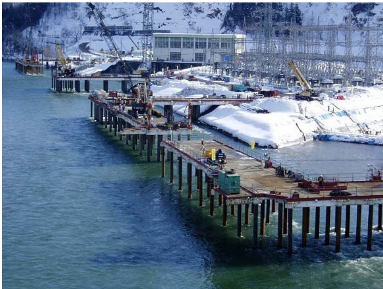
写真-7. 信発新小千谷発電所放水路(護岸)他災害応急
