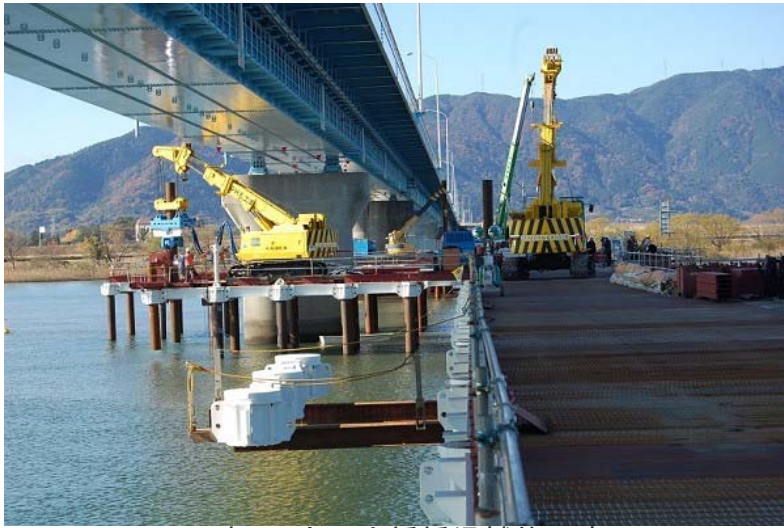
写真-5. 立田大橋橋梁補修工事
