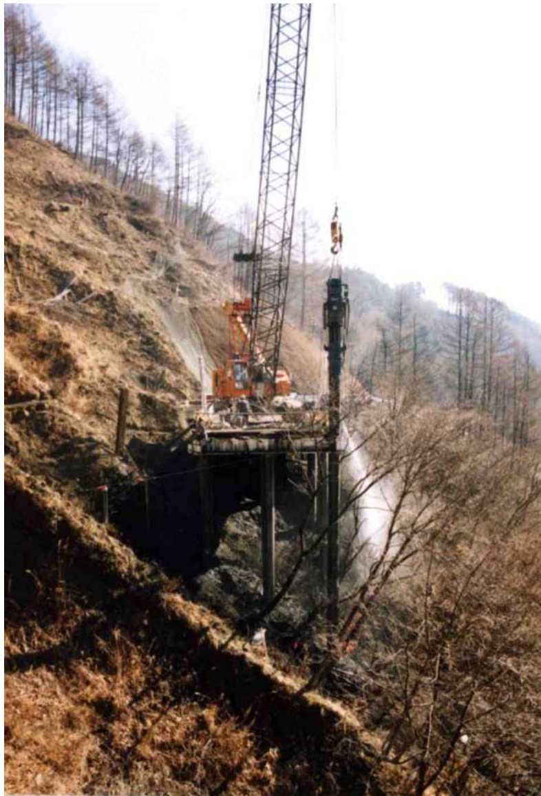
写真-4.上部構造を杭導材とした杭打込み状況
