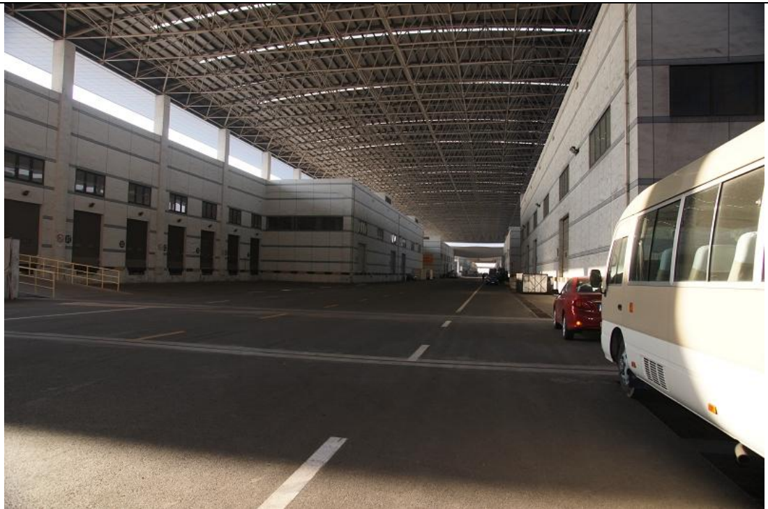
圖片說明：上海外高橋物流中心內兩線輸送用車道。
