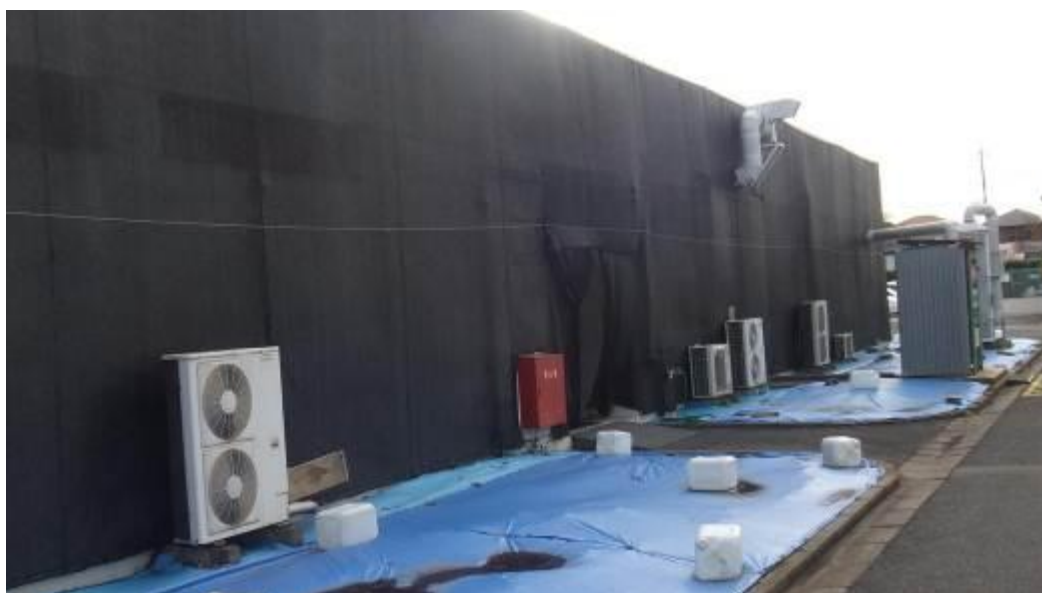
圖 1 為避免輻射塵污染干擾，實驗室建物外均罩以黑網，建物旁灌木均砍伐並在土壤上覆蓋塑膠帆布，以避免再懸浮污染。
