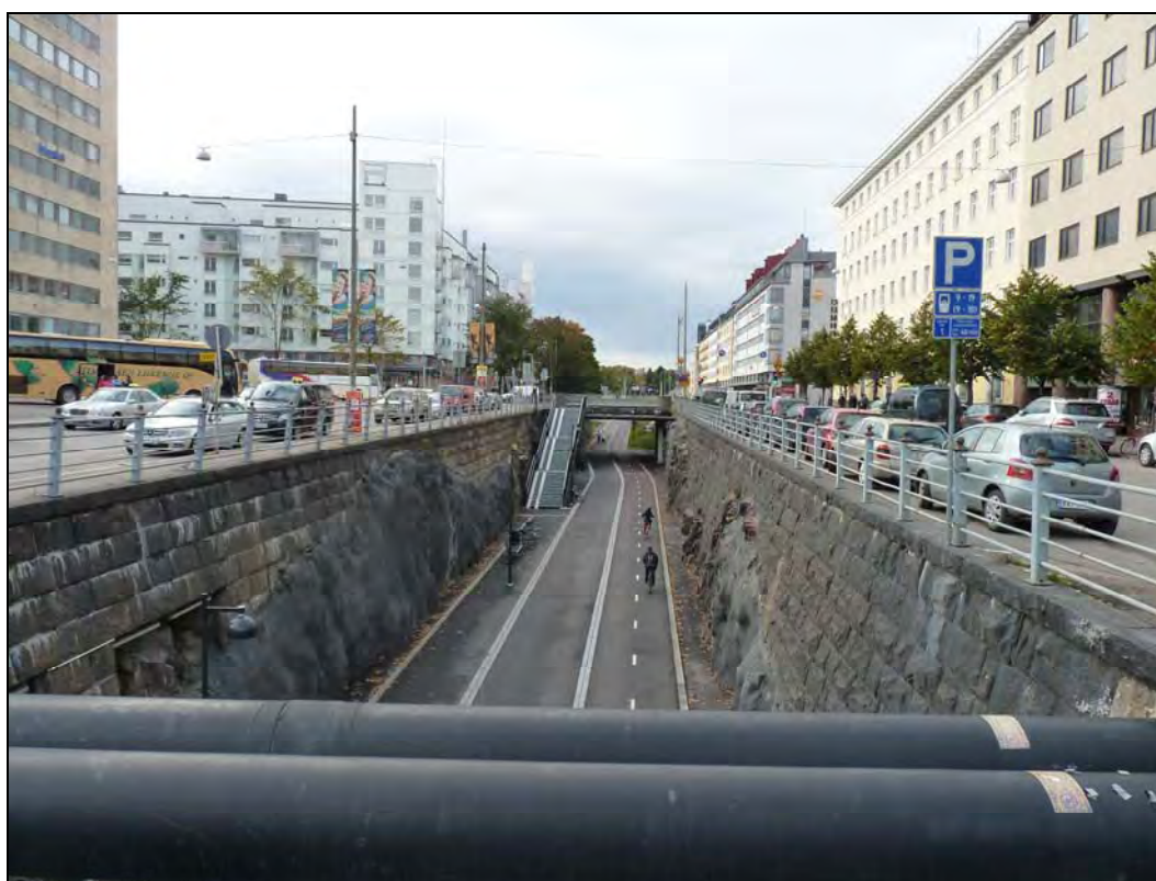
市區人行道及自行車道設置方式（行人及自行車與汽機車完全分離）
