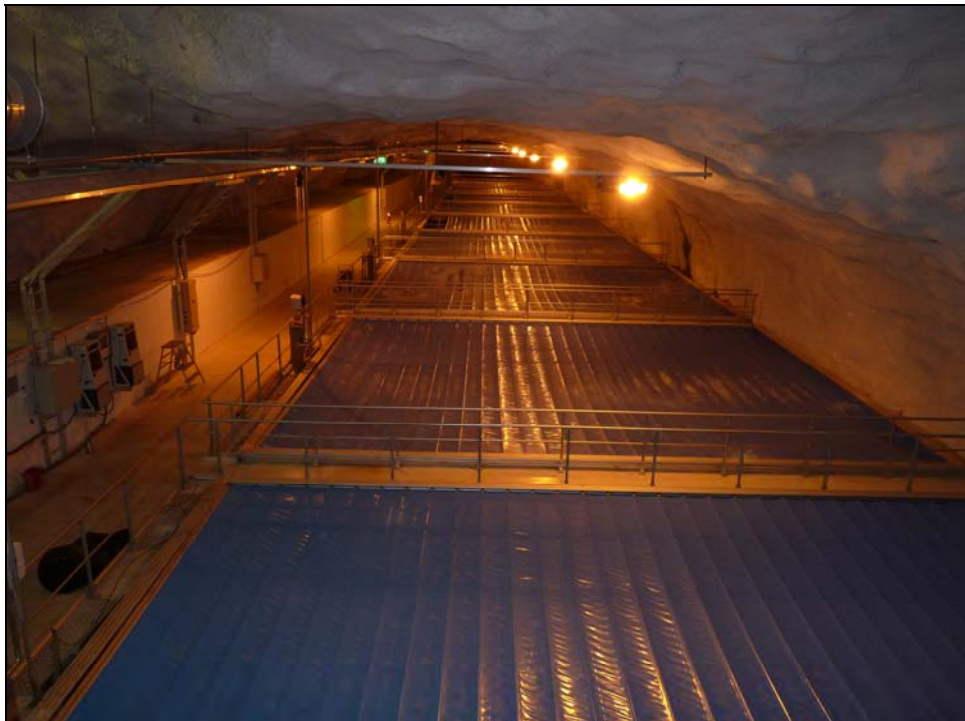
處理池設備加蓋方式（滑動式帆布蓋）
