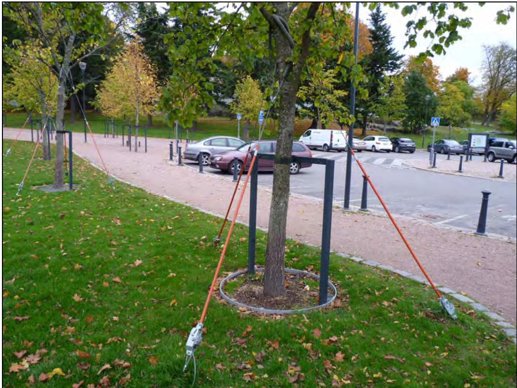
植栽支架設置方式
