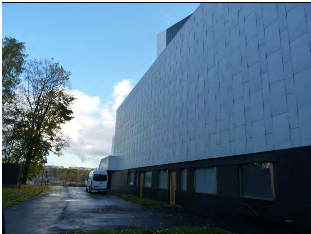
市政中心外牆形式
