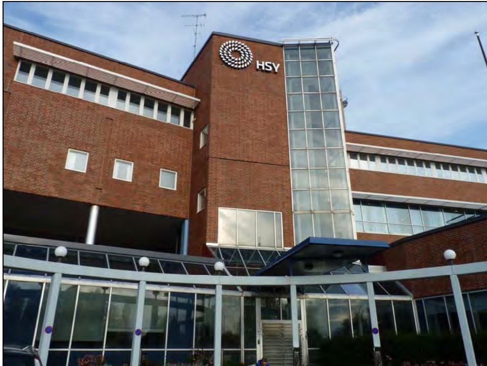
赫爾辛基污水處理廠外觀
