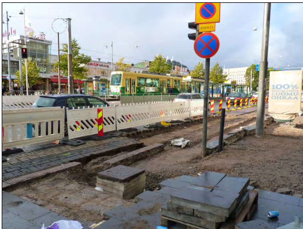
塑膠製施工圍籬及警示措施（輕便、美觀、醒目；適用於小型修繕工程）
