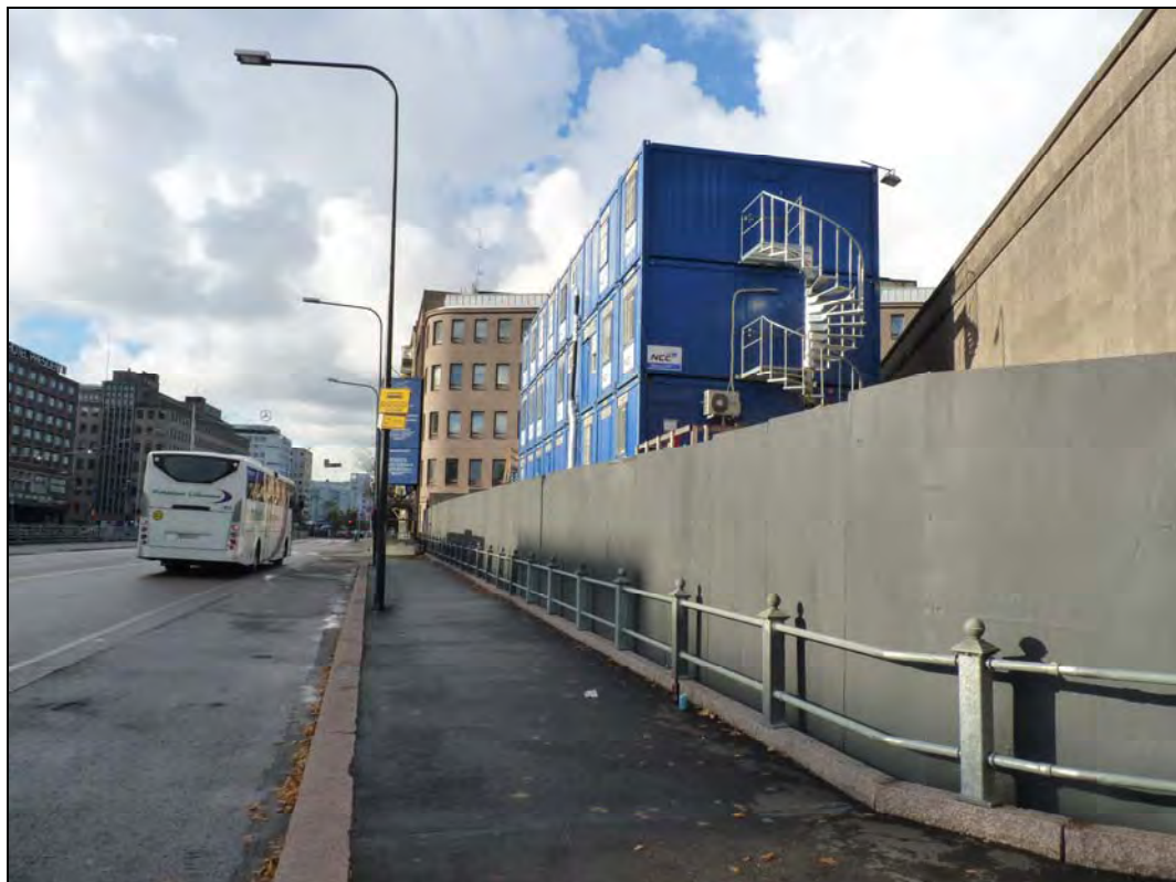
施工圍籬、護欄及工務所
