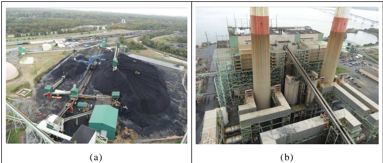
圖 3.3-5 由煙囪 CEMS 設置平台窗口遠眺(a)電廠之貯煤場(b)舊/備用排放管道
