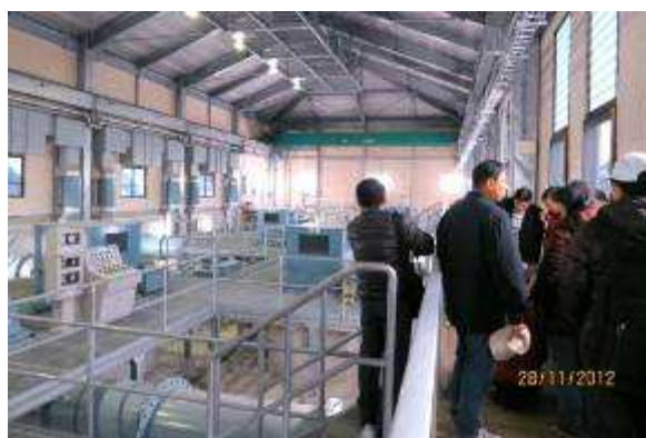
參觀兩總用水第一揚水機廠設備
