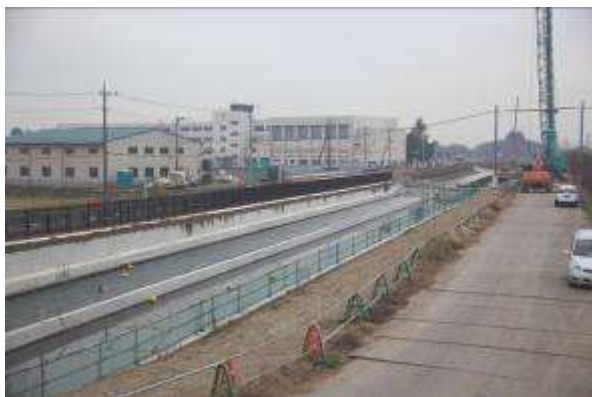
利根導水綜合事業所武藏水路上游段改善工程施工現場
