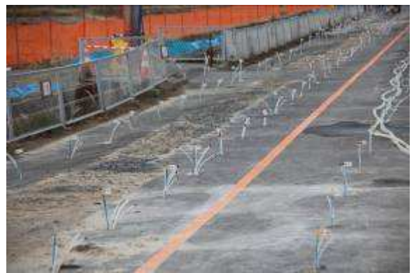
地盤改良「超多點注入工法」施工現場
