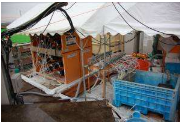
地盤改良「超多點注入工法」加壓儀器
