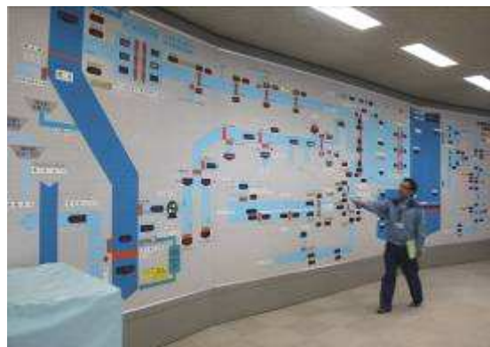
利根導水綜合事業所輸送水控制盤
