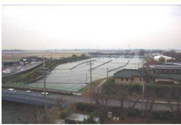
利根導水路分水工
