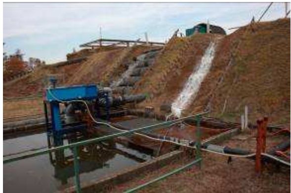
土堤溢流試驗
