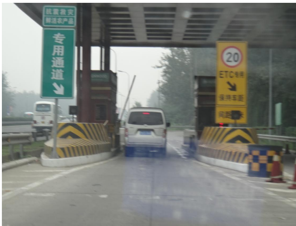
圖 7 北京市高速公路收費站無論內側人工收費車道或外側 ETC 車道皆有柵欄阻隔於車道上
