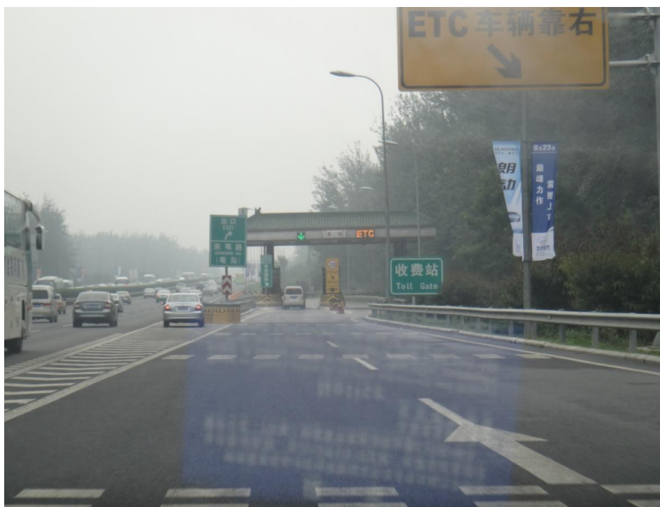
圖 4 北京市高速公路 ETC 車道皆佈置於收費站外側 (不同於台灣高速公路小汽車 ETC 車道佈置於內側)
