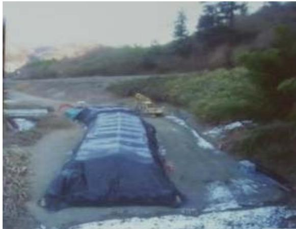
圖五 挖起的污染土壤暫放圖
