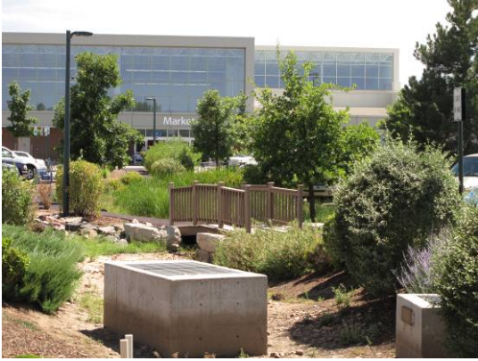
貯洪池出水口(一)水口在直上方
