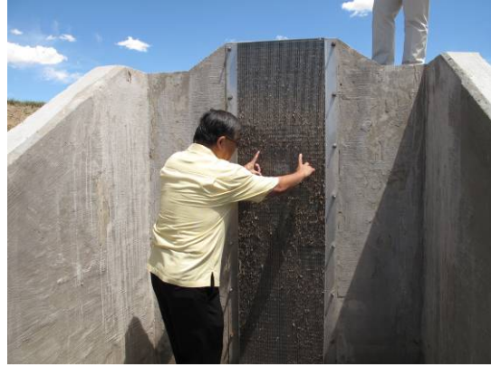
貯洪池出水口(二)水口在側面
