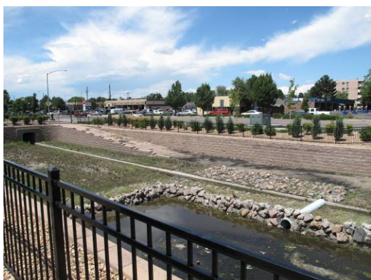
商業區末端貯洪池(一)設有清理道路
