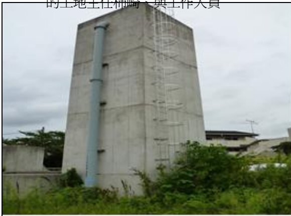
太尾、駒岡整備工事豎井（從這邊到地下 60 公尺）
