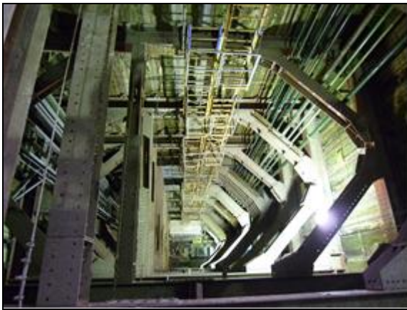
太尾工區施工豎井
