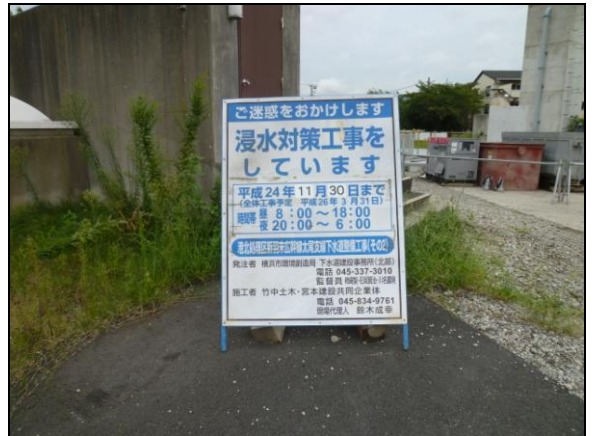
太尾、駒岡整備工事看板
