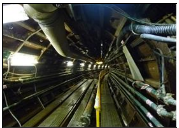
太尾工區施工中雨水幹管隧道
